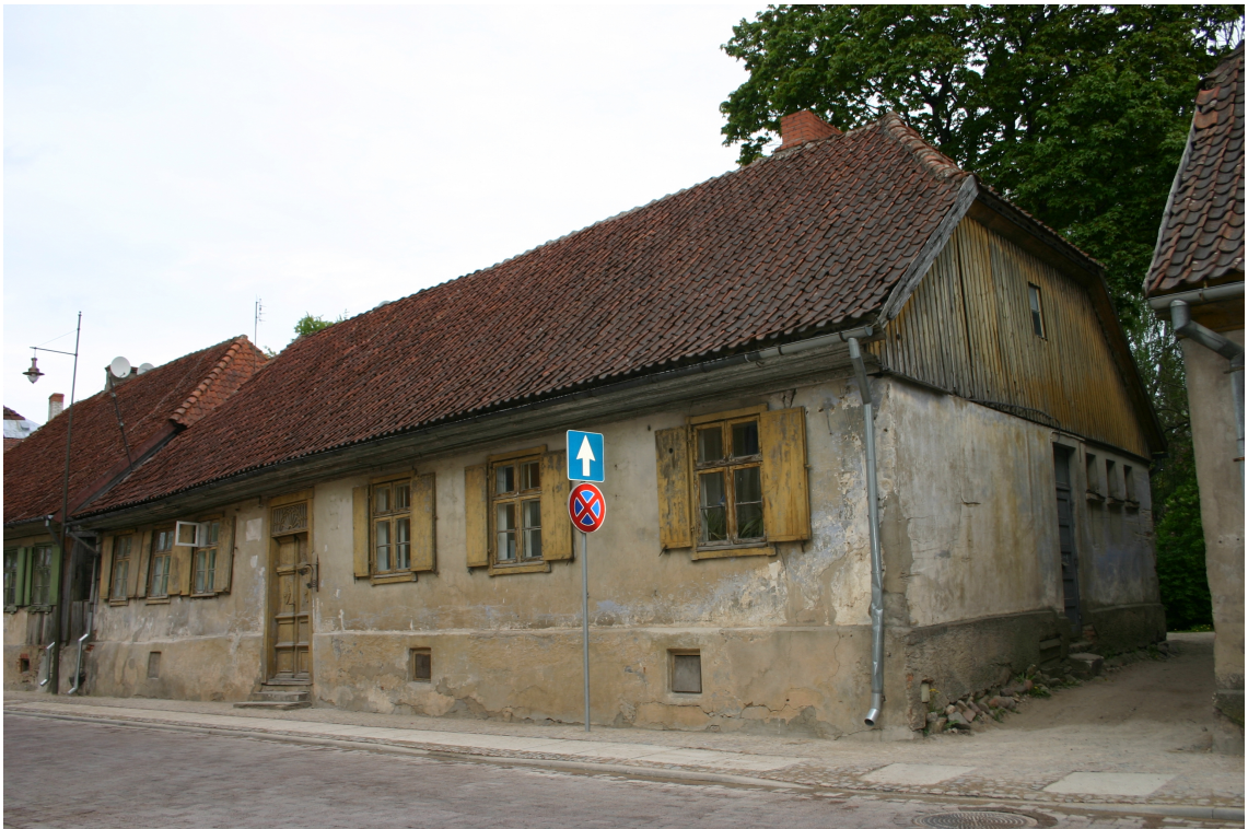
Kalna_13_62010220072001_fasade2 Skats uz ēku no dienvidrietumiem.
