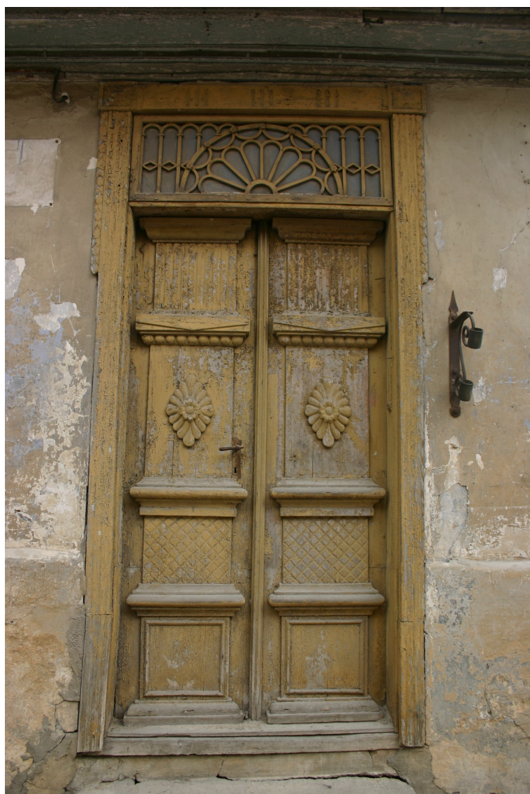
Kalna_13_62010220072001_durvis1 Sākotnējs (1813.-1829.g.) durvju komplekts ar oriģinālo aprīkojumu un apmalēm Vērtnes pagarinātas par vienu pildiņu (domājams, 19.gs.b., 20.gs.sāk.).
