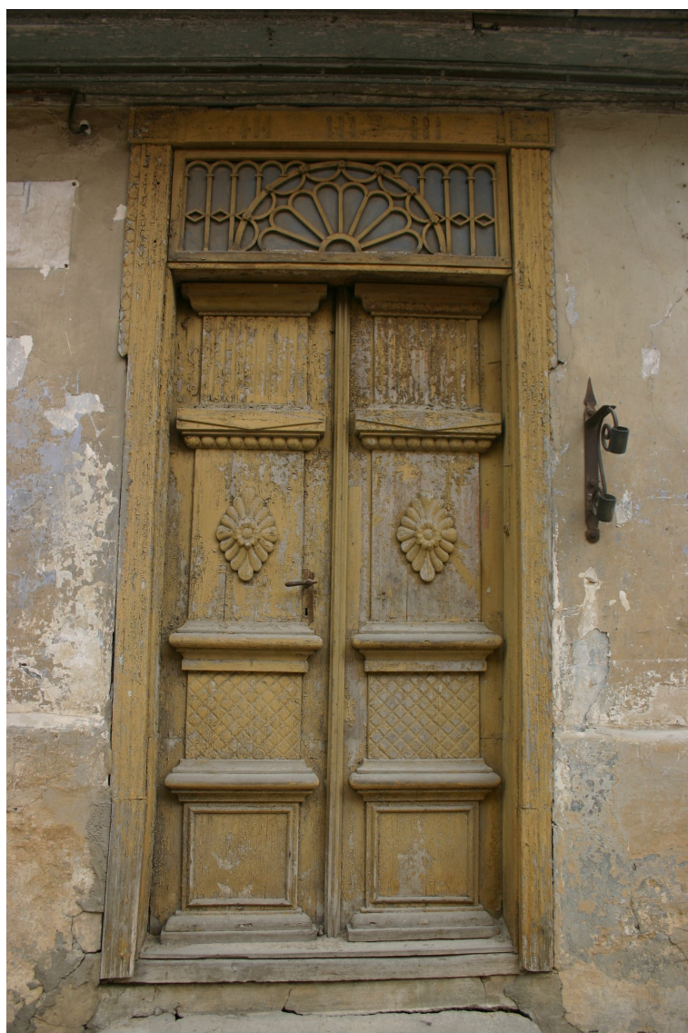
Kalna_13_62010220072001_durvis1 Sākotnējs (1813.-1829.g.) durvju komplekts ar oriģinālo aprīkojumu un apmalēm Vērtnes pagarinātas par vienu pildiņu (domājams, 19.gs.b., 20.gs.sāk.).
