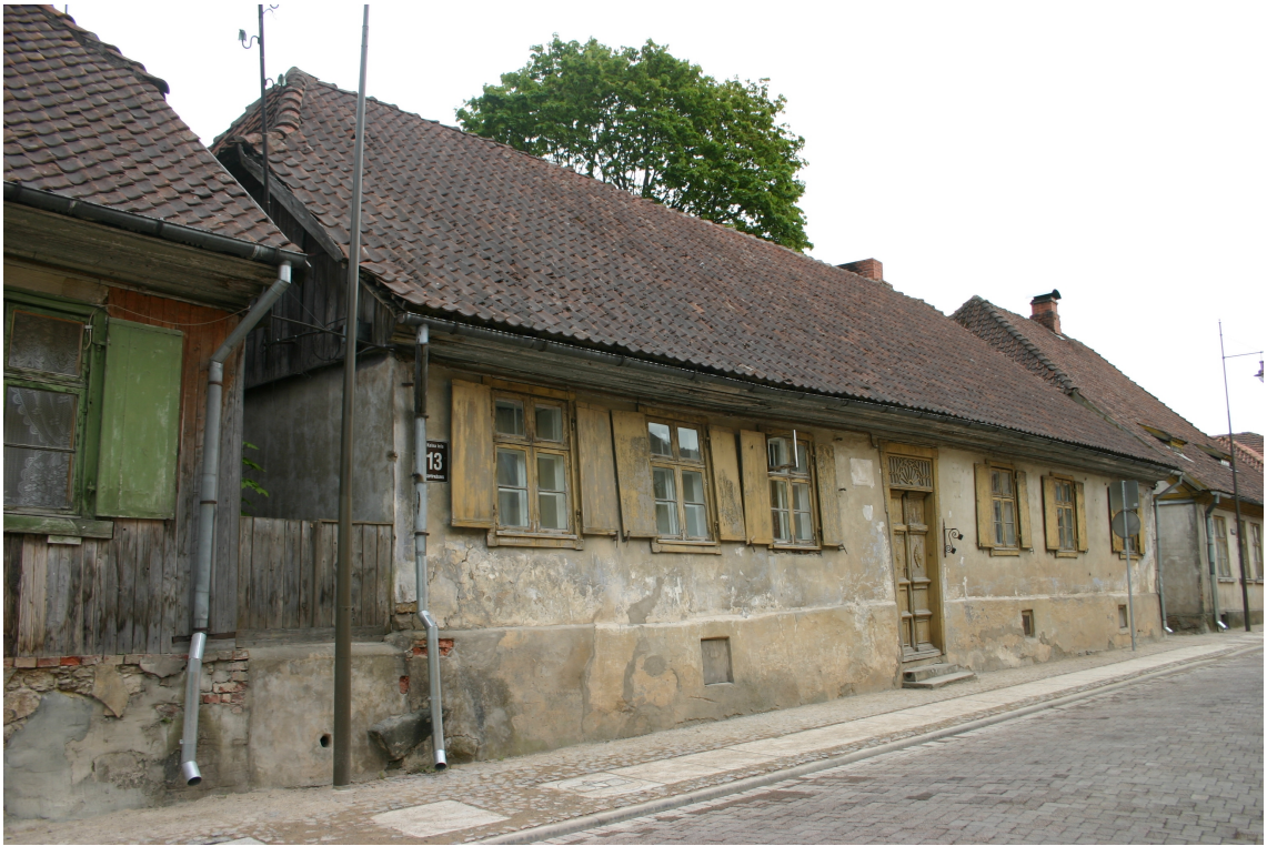
Kalna_13_62010220072001_fasade1 Skats uz ēku no ziemeļrietumiem.
