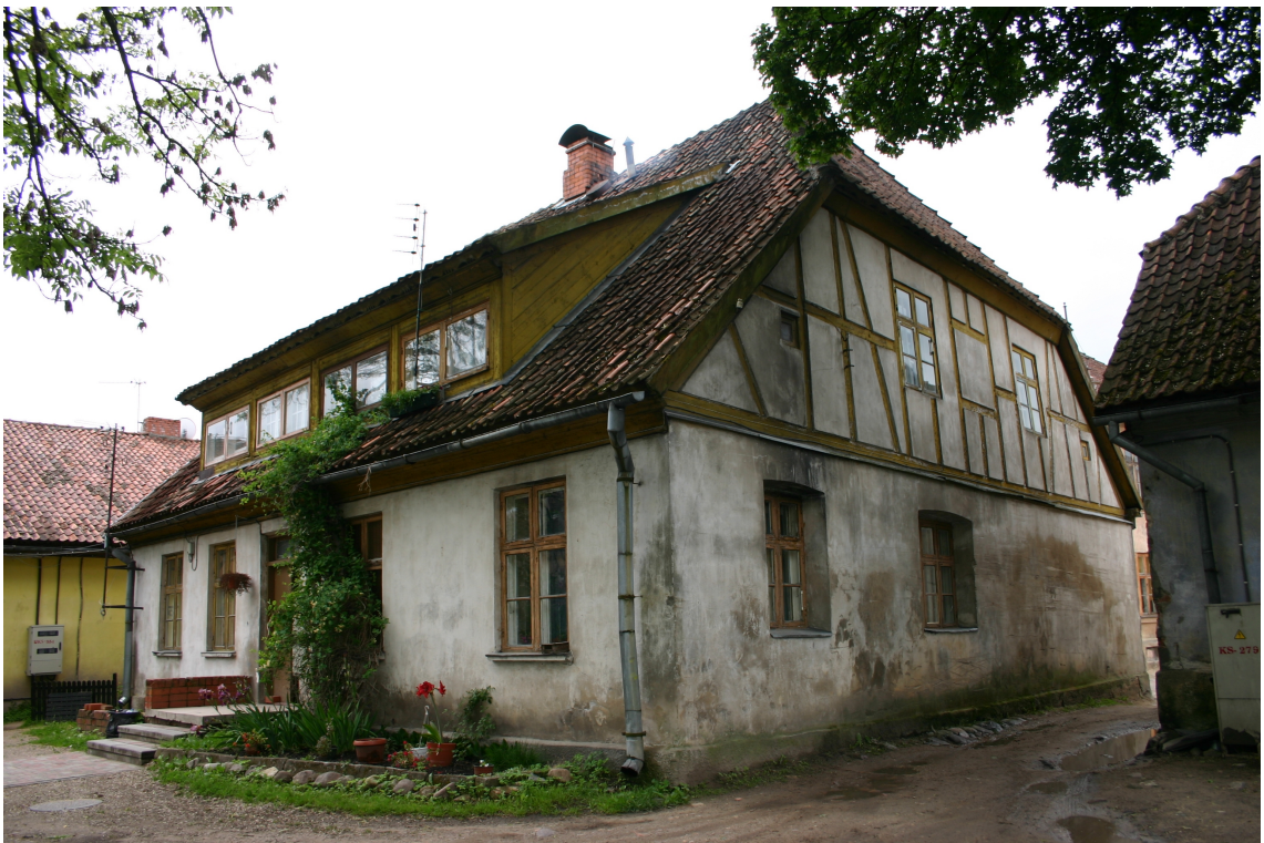
Kalna_11_62010220071001_fasade2 Skats uz ēku no ziemeļaustrumiem. Jumta izbūve – 20.gs.2.puse.
