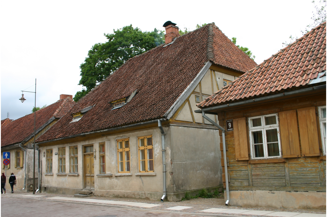
Kalna_11_62010220071001_fasade1 Skats uz ēku no dienvidrietumiem.
