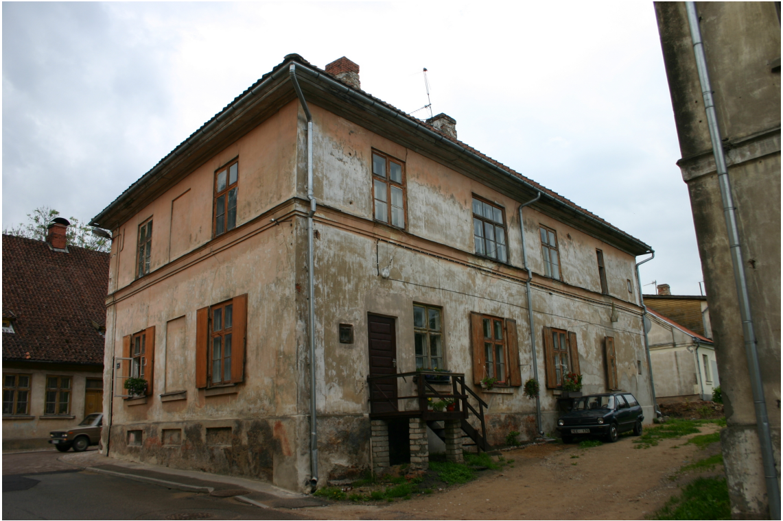
Kalna_10_62010220052001_fasade3 Skats uz ēku no ziemeļrietumiem.
