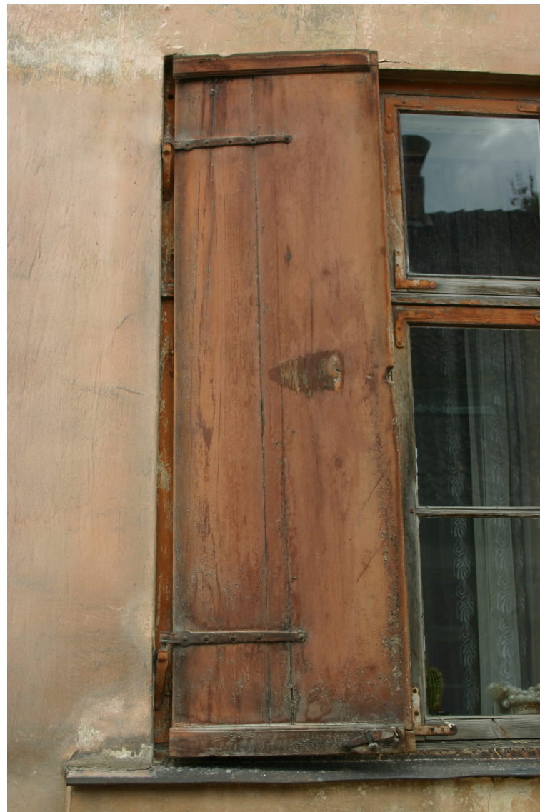
Kalna_10_62010220052001_slegi1 Sākotnējais (19.gs.3.cet.) slēģis ar oriģinālo aprīkojumu.
