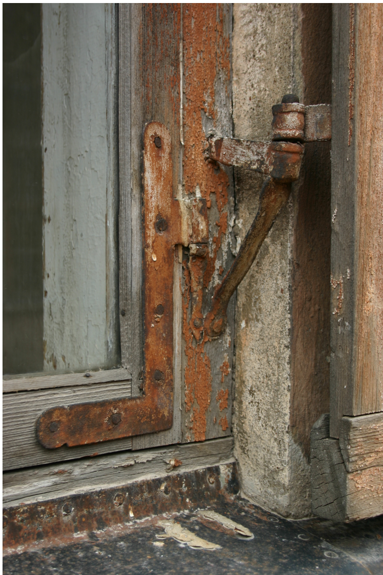
Kalna_10_62010220052001_logs2 Sākotnējā (19.gs.3.cet.) loga un slēga aprīkojums.
