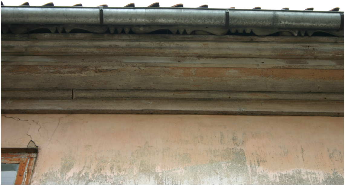
Kalna_10_62010220052001_dzega2 Sākotnējā (19.gs.3.cet.) dēļu dzega un kokā griezts aizsegdēlis.
