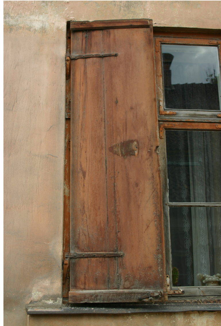
Kalna_10_62010220052001_slegi1 Sākotnējais (19.gs.3.cet.) slēģis ar oriģinālo aprīkojumu.
