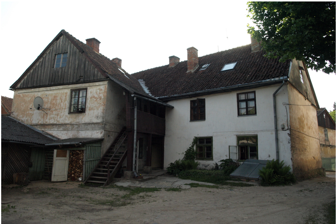
Kalna1_62010220070001_fasade3 Skats uz ēku no austrumiem. Koka galerijai un kāpnēm saglabājusies vēsturiskā konstrukcija.
