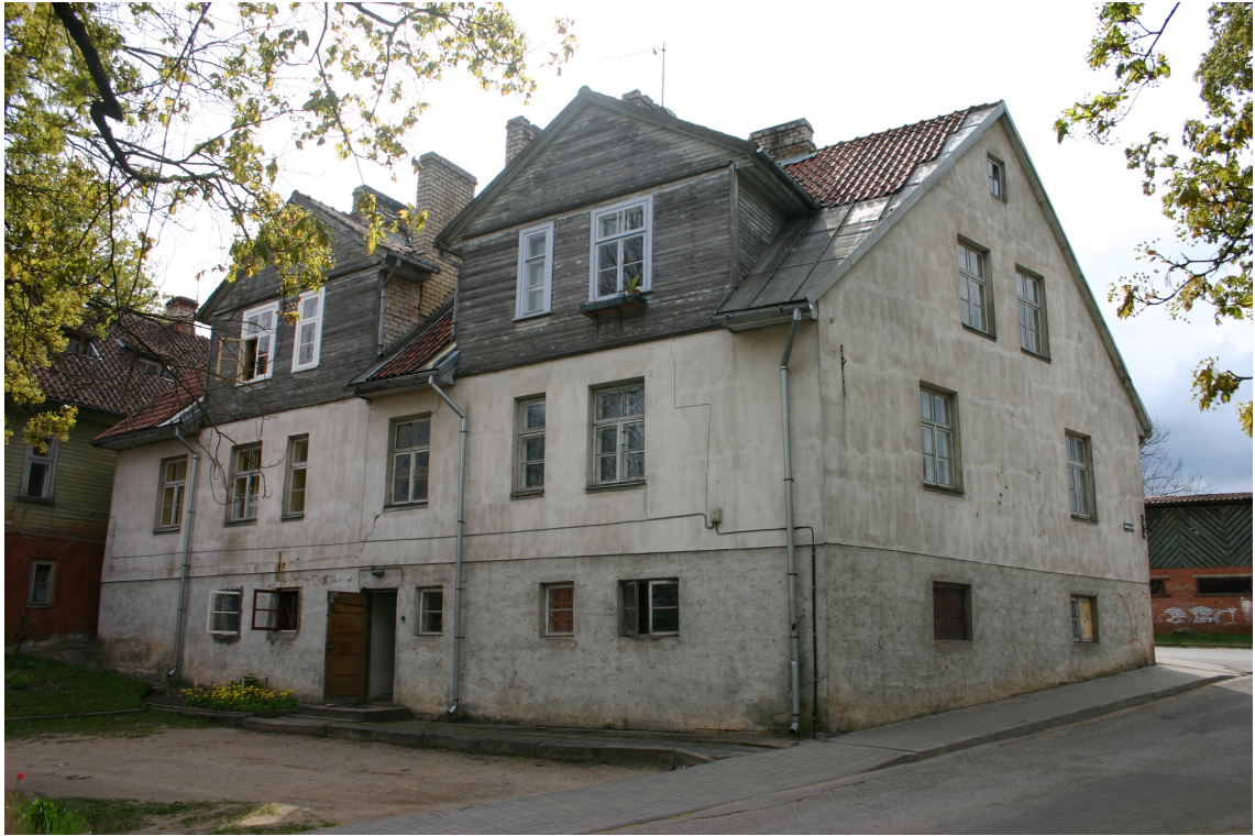
Kaljku_7_62010050052001_fasade3 Skats uz ēku no ziemeļaustrumiem.
