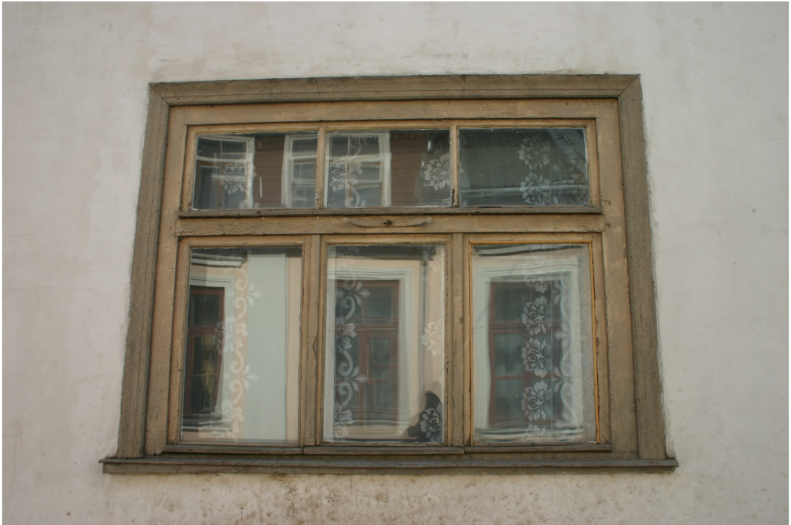
Kaljku_6_62010060019001_logs1 Sākotnējais logs (20.gs.30.gadi) austrumu fasādē.
