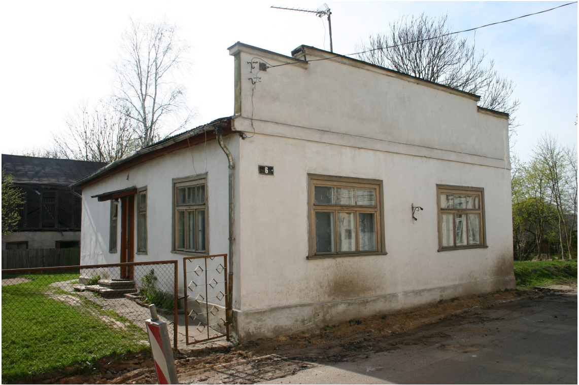
Kaljku_6_62010060019001_fasade1 Skats uz ēku no dienvidaustrumiem.
