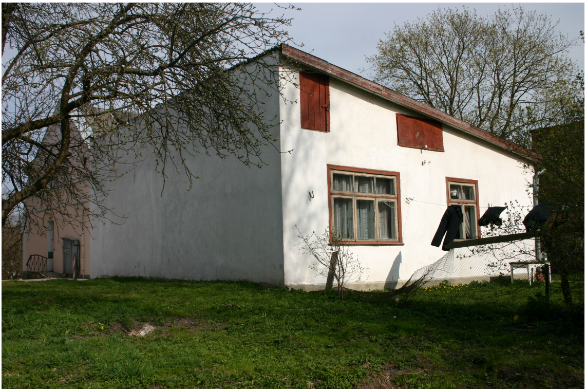
Kaljku_6_62010060019001_fasade2 Skats uz ēku no ziemeļrietumiem.
