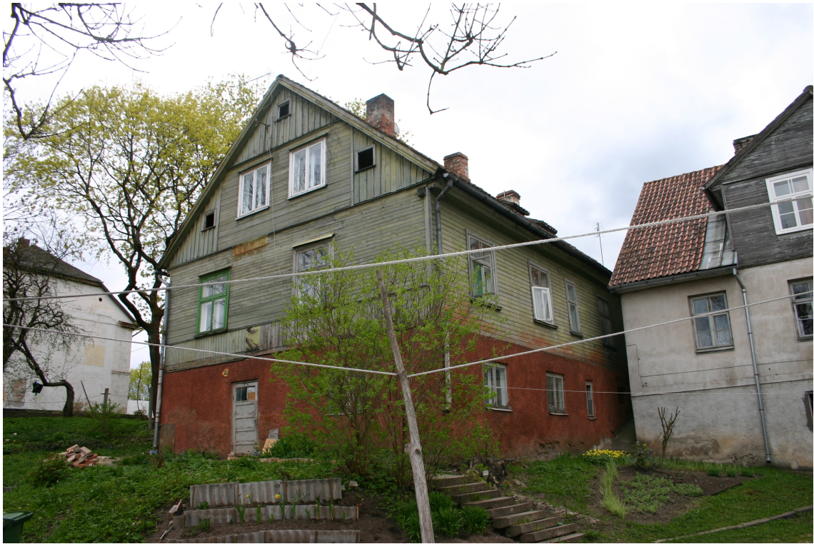
Kaljkju_5_62010060012001_fasade3 Skats uz ēku no ziemeļiem.
