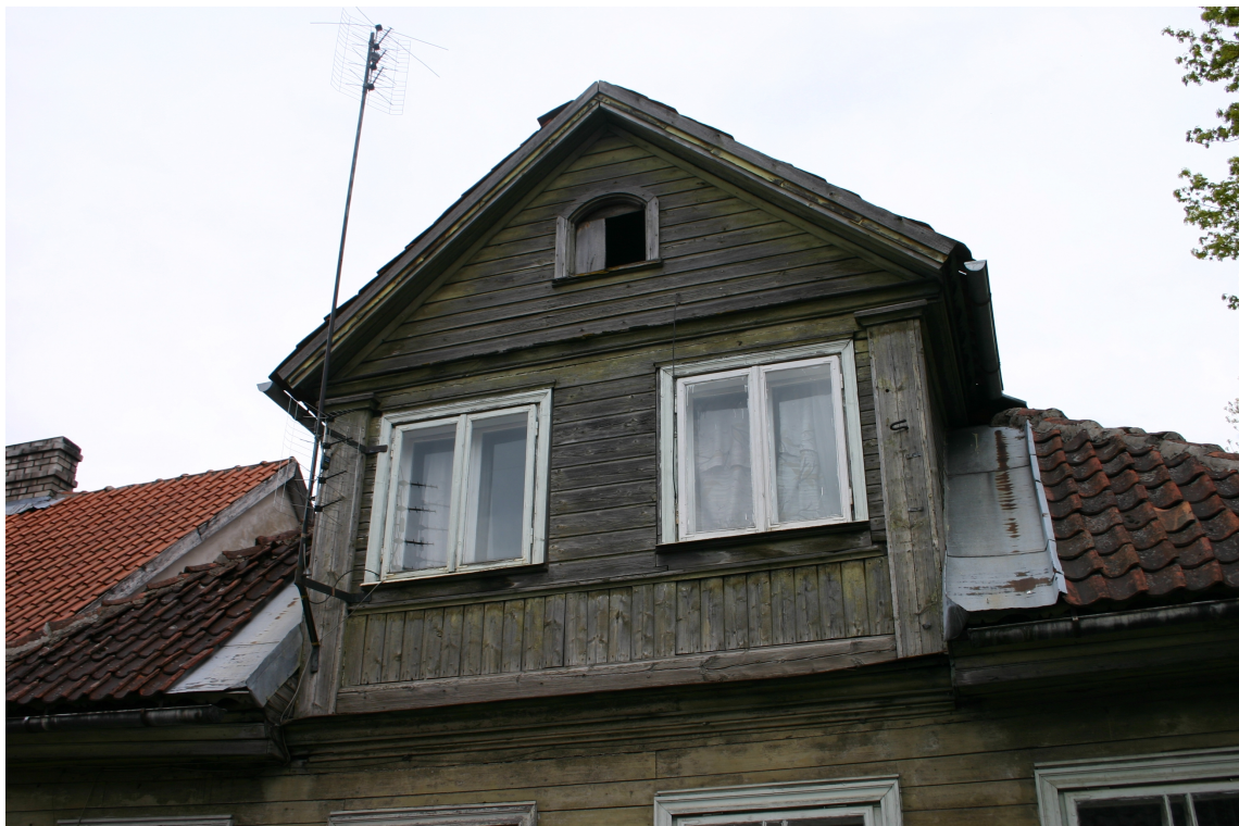
Kaljkju_5_62010060012001_fragments1 Sākotnējs (1870to gadu sāk.-1879.g.) mezonīns ielas fasādē. Mezonīna apšuvums un dekoratīvā apdare – 20.gs.2.puse.
