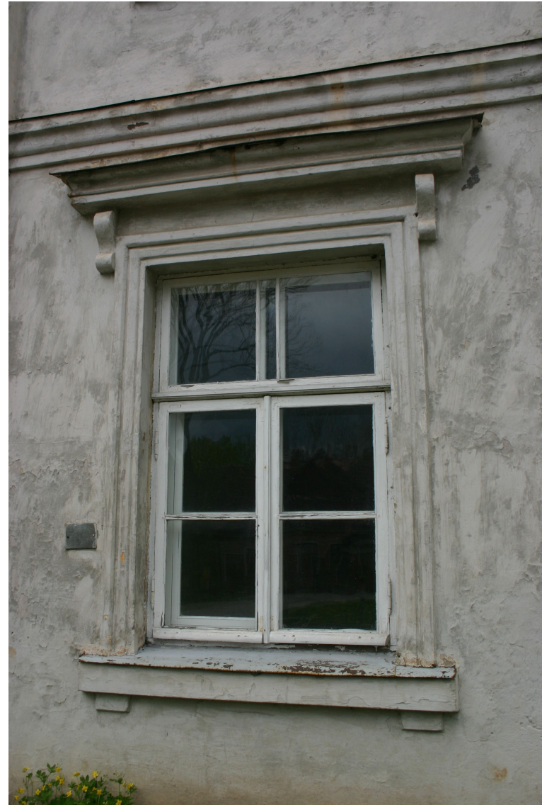
Kaljku_3_62010060022001_logs1 Sākotnējais (19.gs.3.cet.) logs ar oriģinālo aprīkojumu un logailas apdari.
