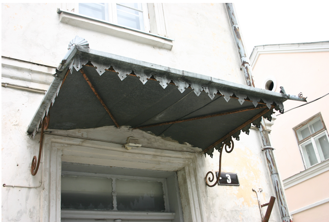
Kaljkju_3_62010060022001_fragments2 Jumtiņš virs galvenajām ieejas durvīm. Jumtiņa konstrukcija sākotnēja (19.gs.3.cet.), skārds ieklāts 20.gs.beigās.
