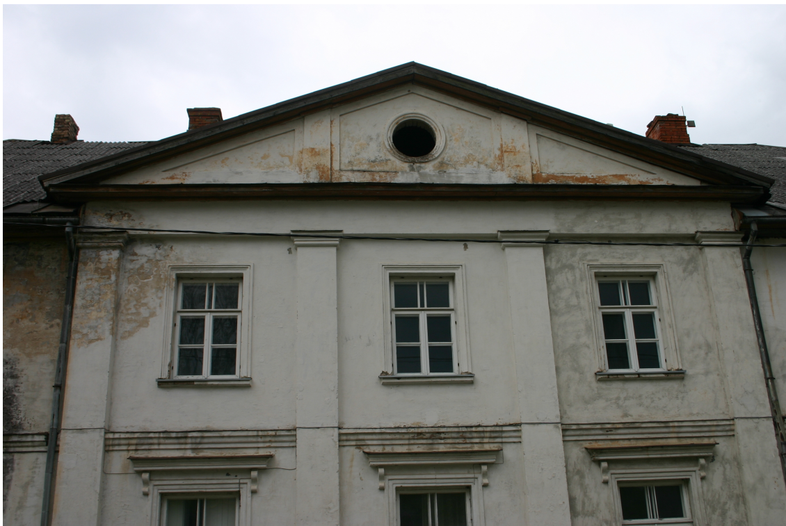
Kaljku_3_62010060022001_fragments1 Galvenās fasādes centrālās daļas fragments ar sākotnējo (19.gs.3.cet.) dekoratīvo apdari.
