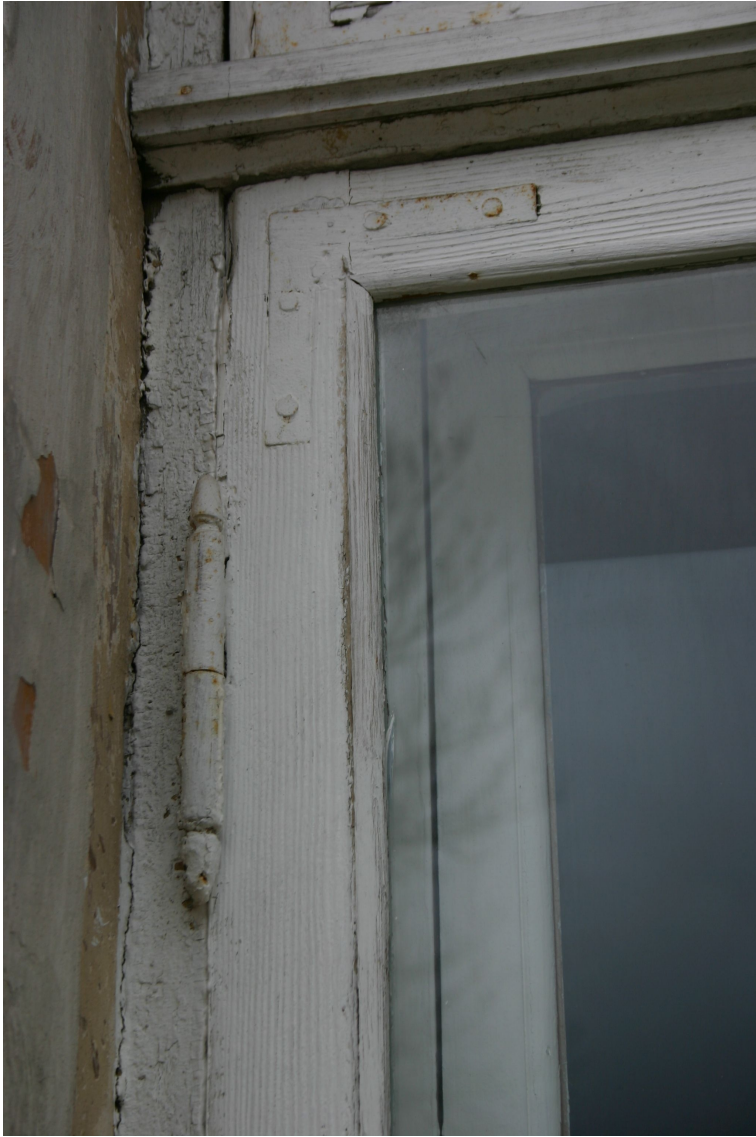
Kaljku_3_62010060022001_logs2 Sākotnējā (19.gs.3.cet.) loga vira un stūrenis.
