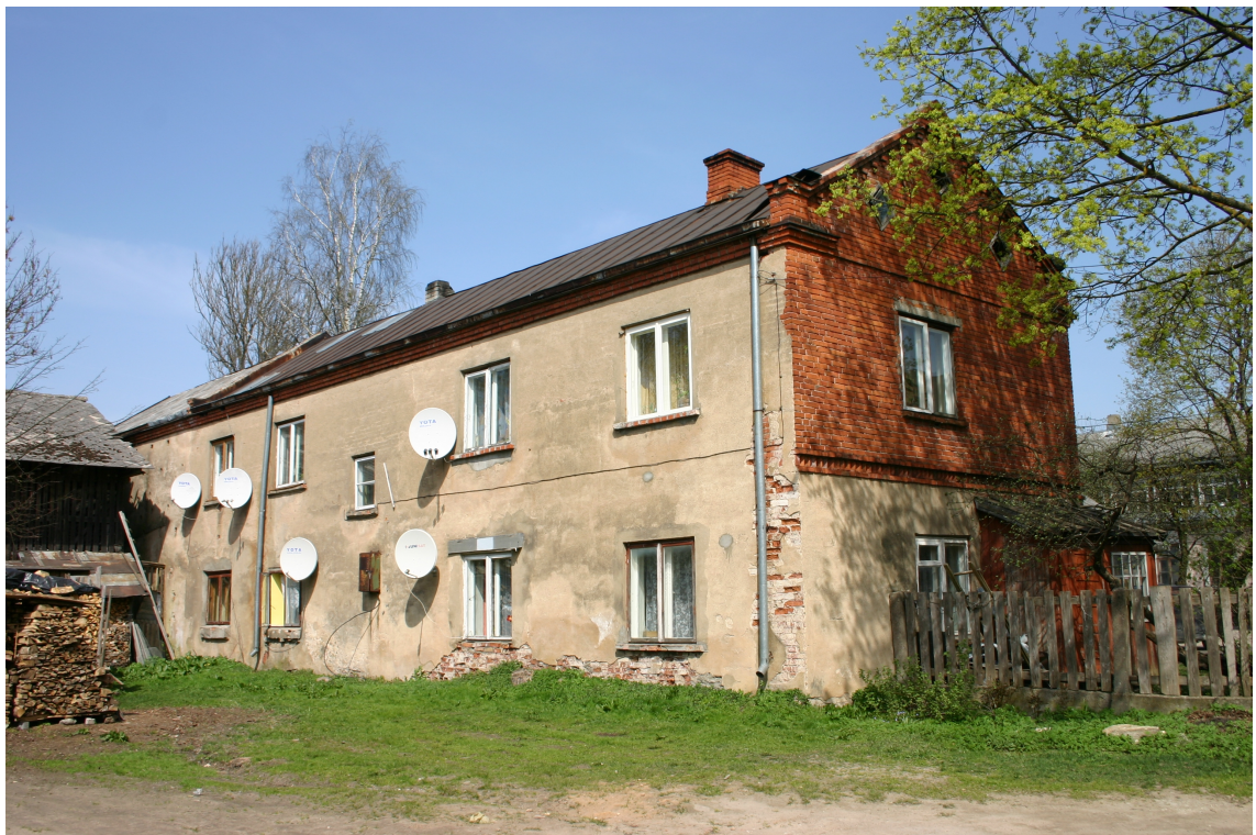
Kaljku_2_62010060013002_fasade2 Skats uz ēku no dienvidrietumiem. Ailojums un apmetums rietumu fasādē izveidoti 20.gs.2.pusē.
