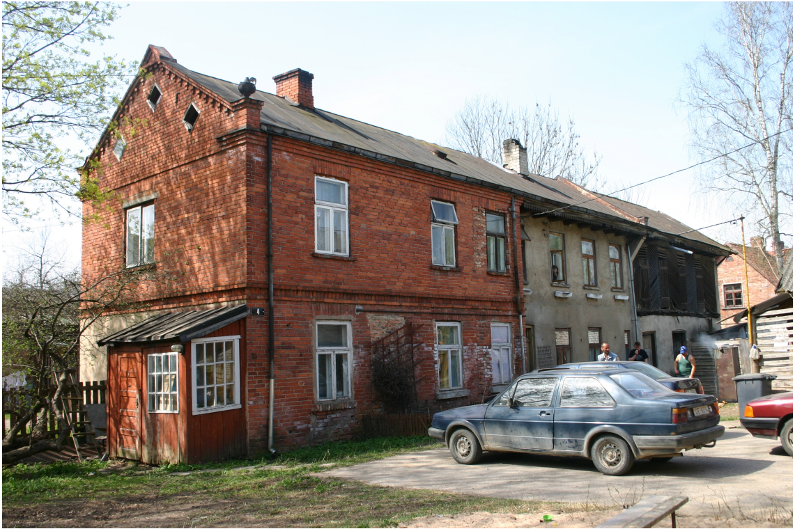
Kaljku_2_62010060013002_fasade1 Skats uz ēku no dienvidaustrumiem. Priekšplānā esošā piebūve – 20.gs.2.puse.
