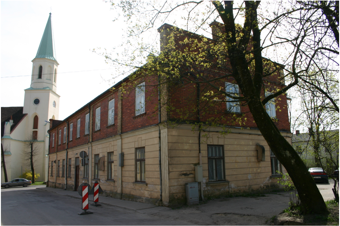
Kaljku_2_62010060013001_fasade3 Skats uz ēku no ziemeļaustrumiem.
