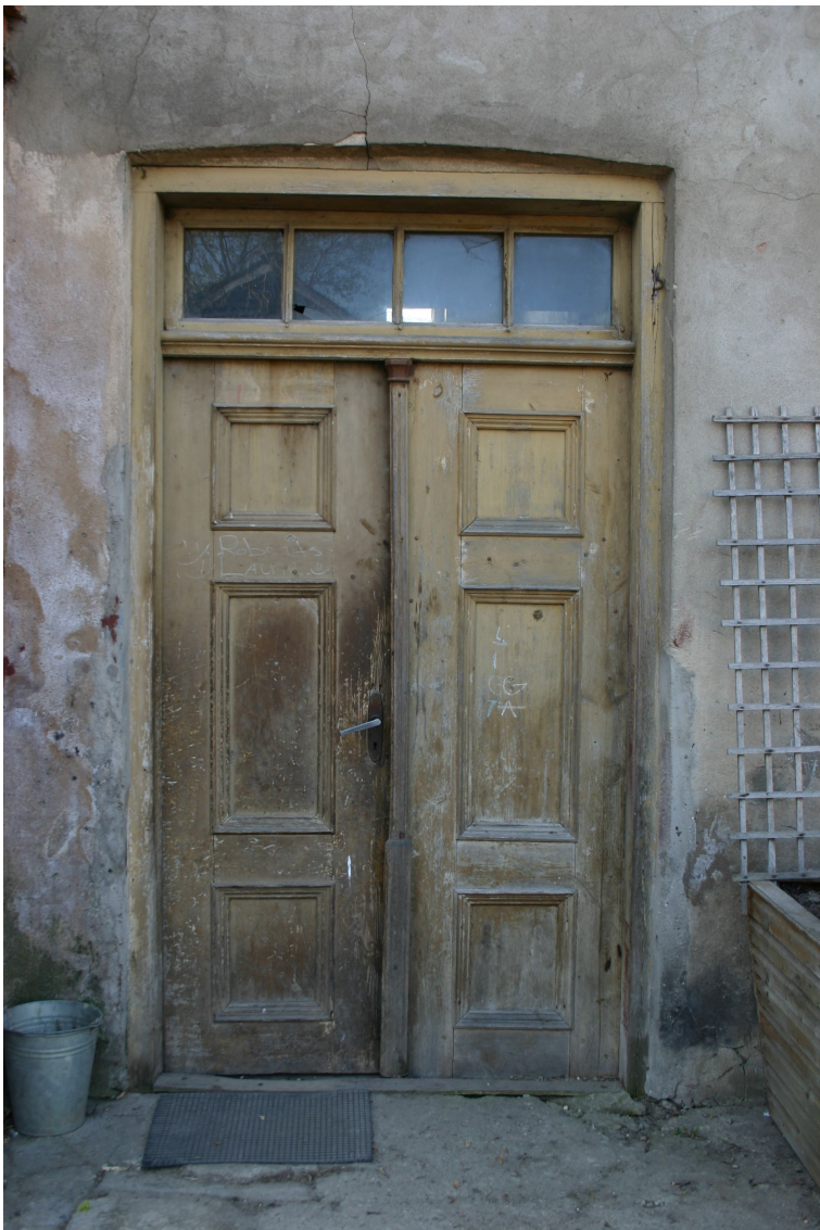
Kaljku_2_62010060013002_durvis1 No vecākas ēkas izmantotas durvis (19.gs.2.puse).
