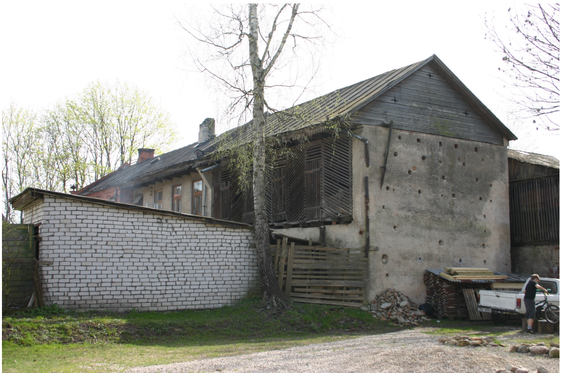
Kaljku_2_62010060013002_fasade4 Skats uz ēku no ziemeļaustrumiem.
