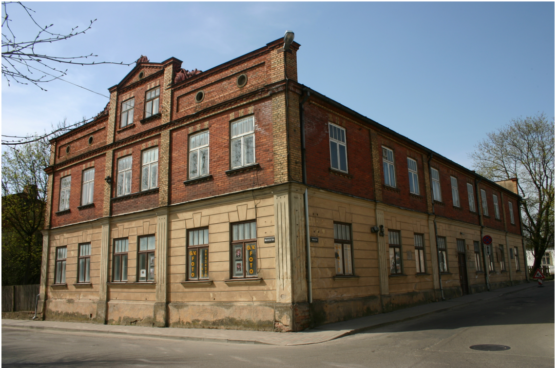
Kaljku_2_62010060013001_fasade2 Skats uz ēku no dienvidaustrumiem.
