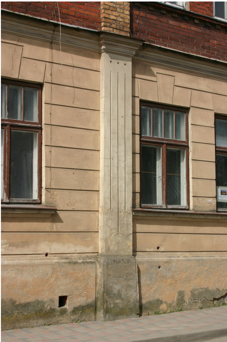
Kaljku_2_62010060013001_fragments2 Dienvidu fasādes fragments ar sākotnējo (1907.g.) fasāžu apdari.
