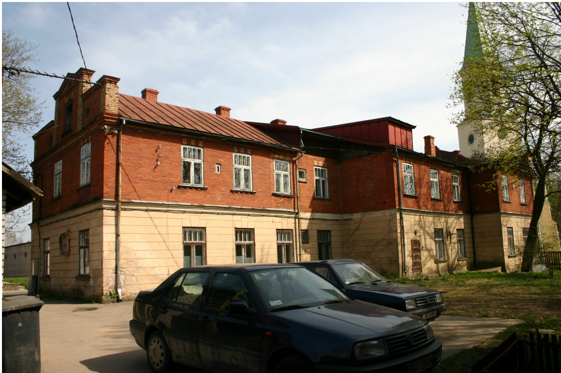
Kaljku_2_62010060013001_fasade4 Skats uz ēku no ziemeļrietumiem
