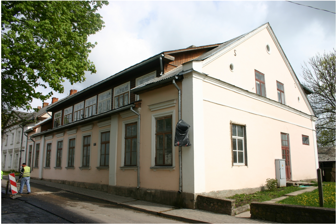
Kaljkju_1_62010060051001_fasade1 Skats uz ēku no dienvidiem. Jumta izbūve izveidota 20.gs.2.pusē.
