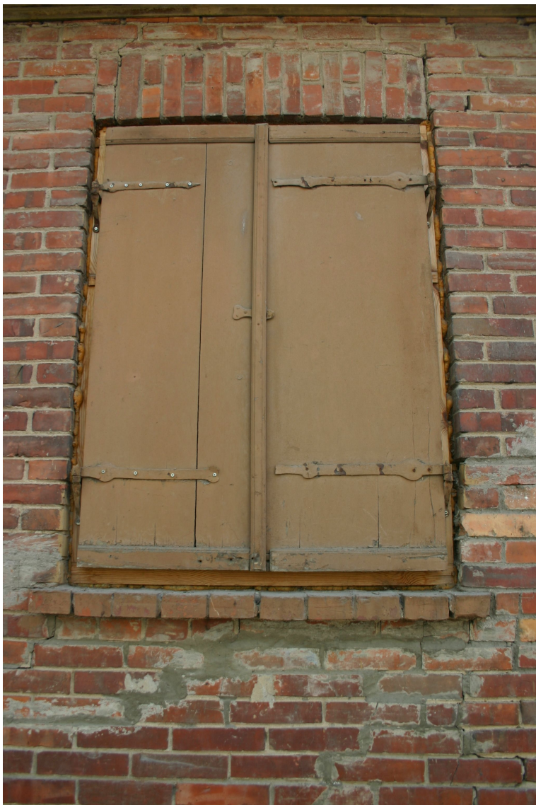
Kaljkju_10_62010060016001_slegis1 Sākotnējie (19.gs.3.cet.) slēgi ar oriģinālo aprīkojumu(izmantotas dažādas, arī vecākas, viras). Slēgi sekundāri apzāģēti.
