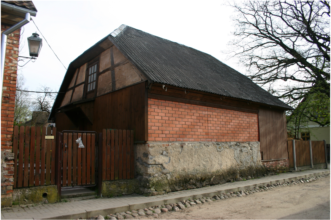
Kaljku_10_62010060016002_003_fasade1 Skats uz ēku no ziemeļaustrumiem.
