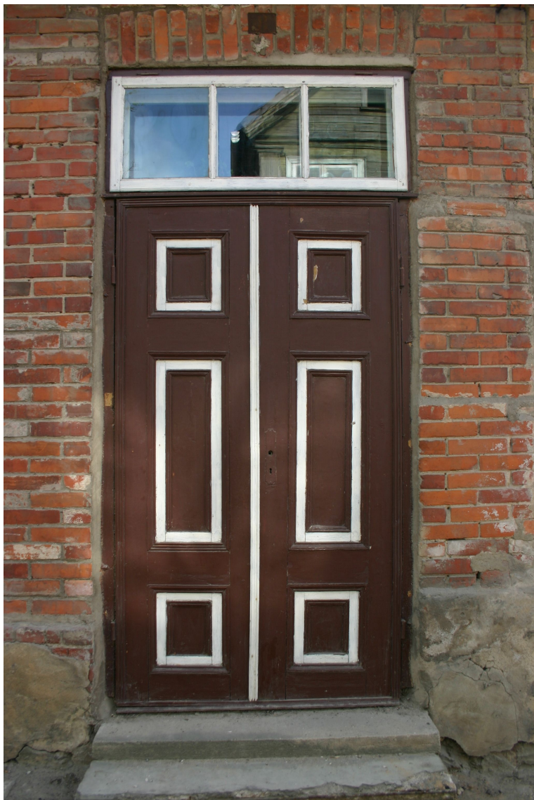
Kaljku_10_62010060016001_durvis1 Sākotnējās (19.gs.3.cet.) ārdurvis ar 20.gs.2.puses virslogu.
