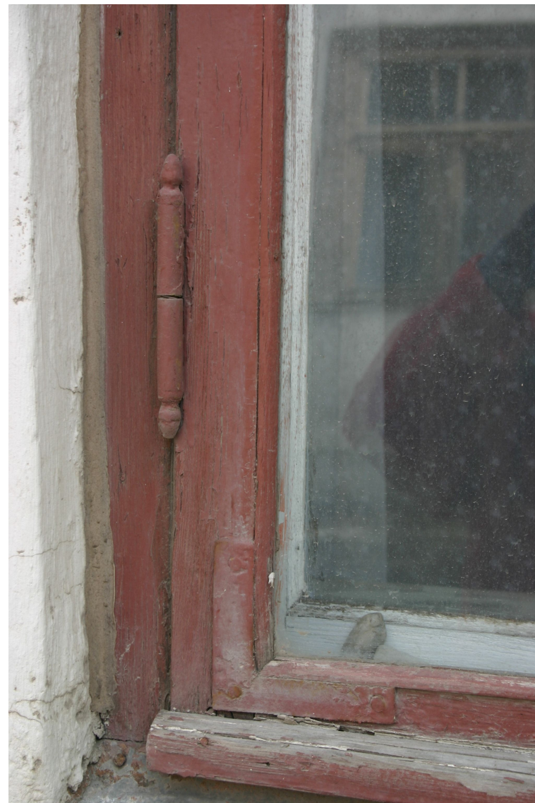
Kaljku_1_62010060051001_logs2 Sākotnējā (19.gs.3.cet.) loga vira un stūrenis.
