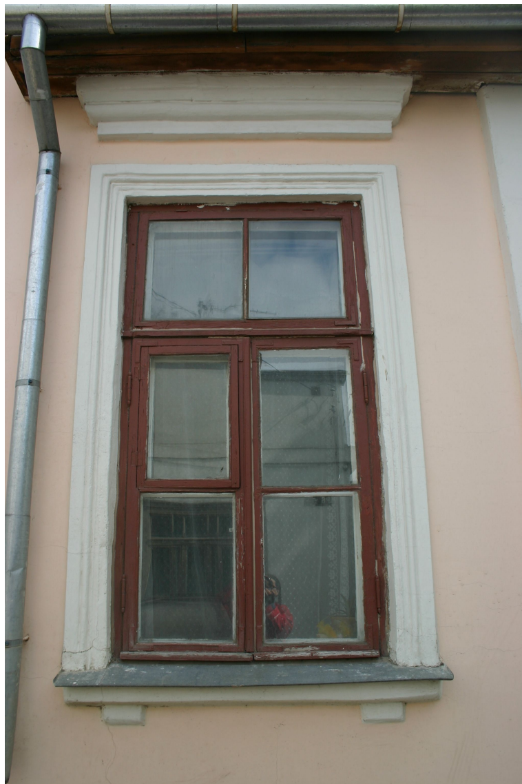
Kaljku_1_62010060051001_logs1 Sākotnējais (19.gs.3.cet.) logs ar oriģinālo aprīkojumu un logailas apdari.
