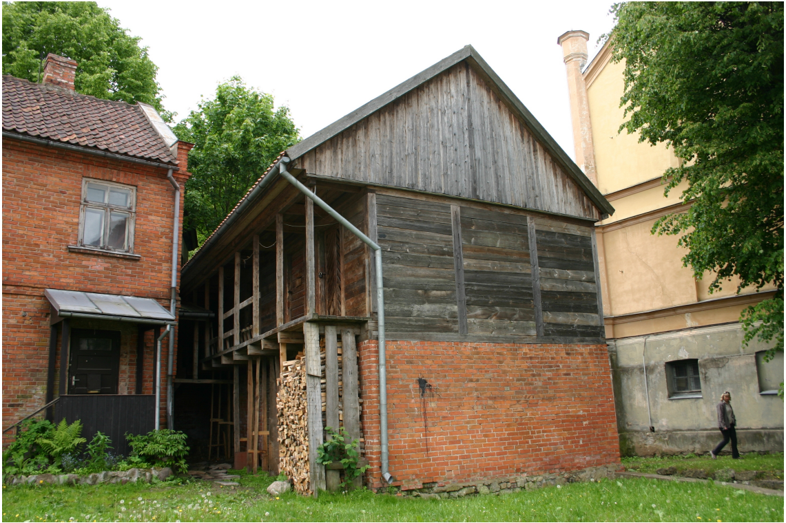
Jelgavas_3_62010220084002_fasade1 Skats uz ēku no ziemeļaustrumiem. 2.stāvs rekonstruēts 1994.gadā.
