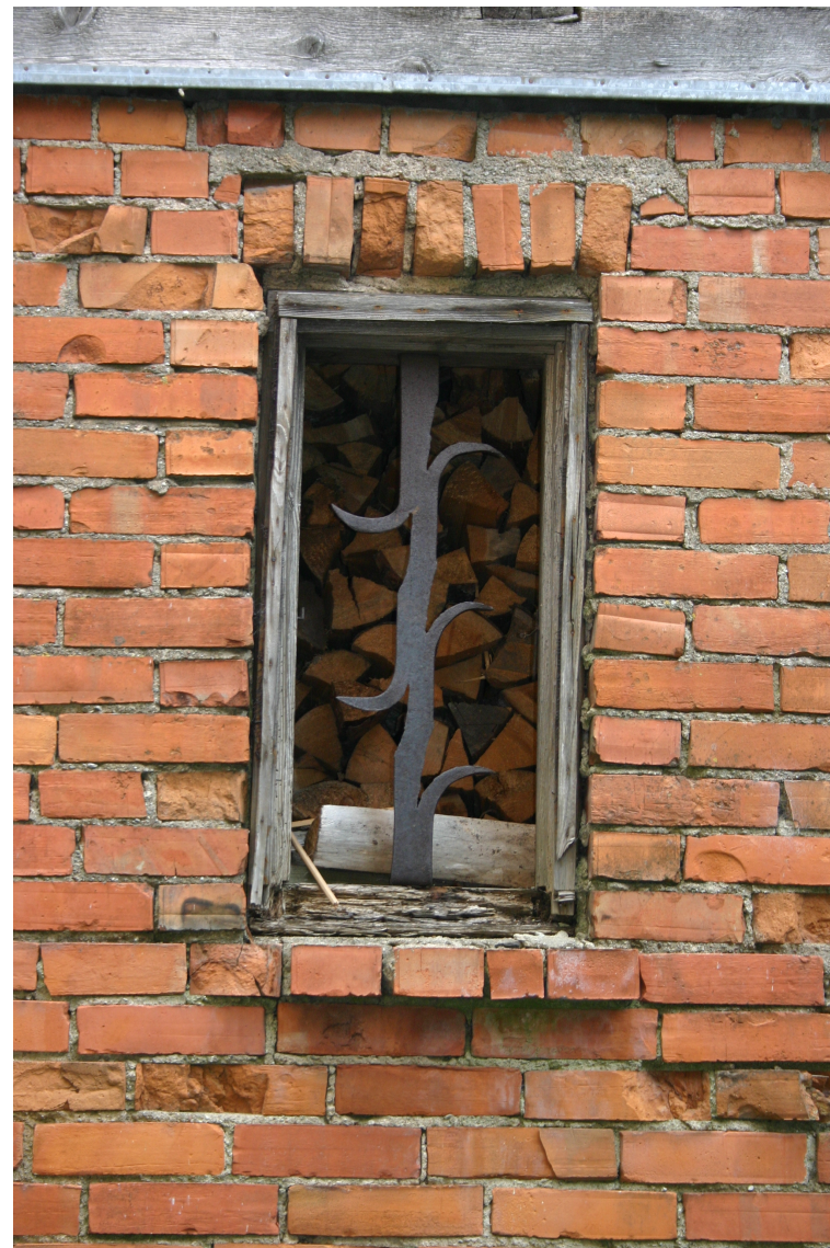
Jelgavas_3_62010220084002_restes Sākotnēja (20.gs.sāk.) loga aploda ar oriģinālajām restēm.
