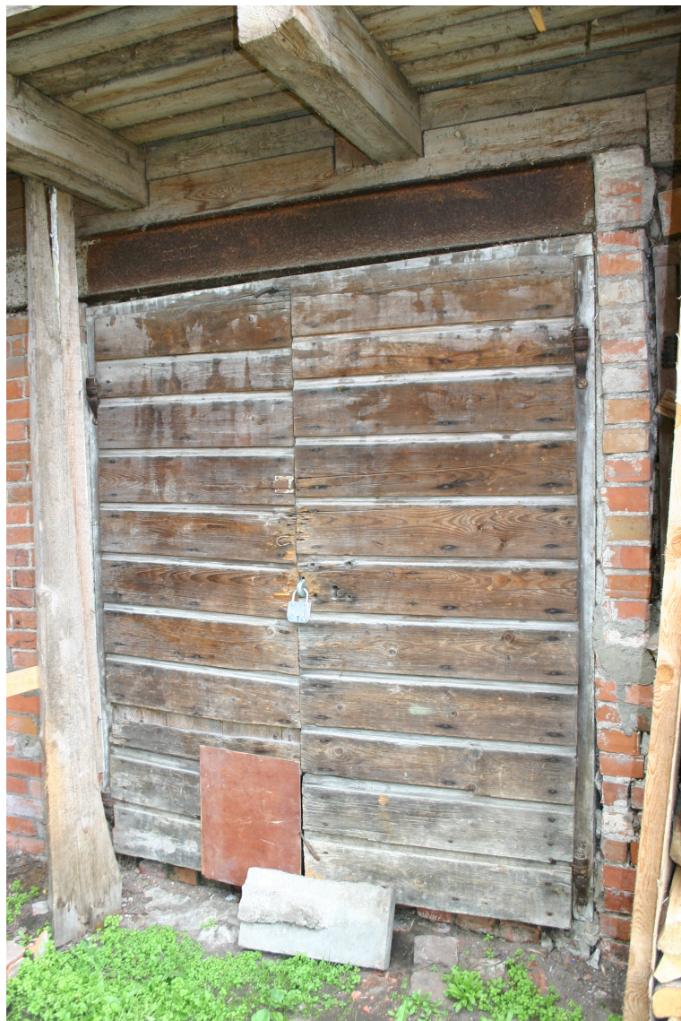
Jelgavas_3_62010220084002_durvis1 Sākotnējas (20.gs.sāk.) durvis ar oriģinālo aprīkojumu.
