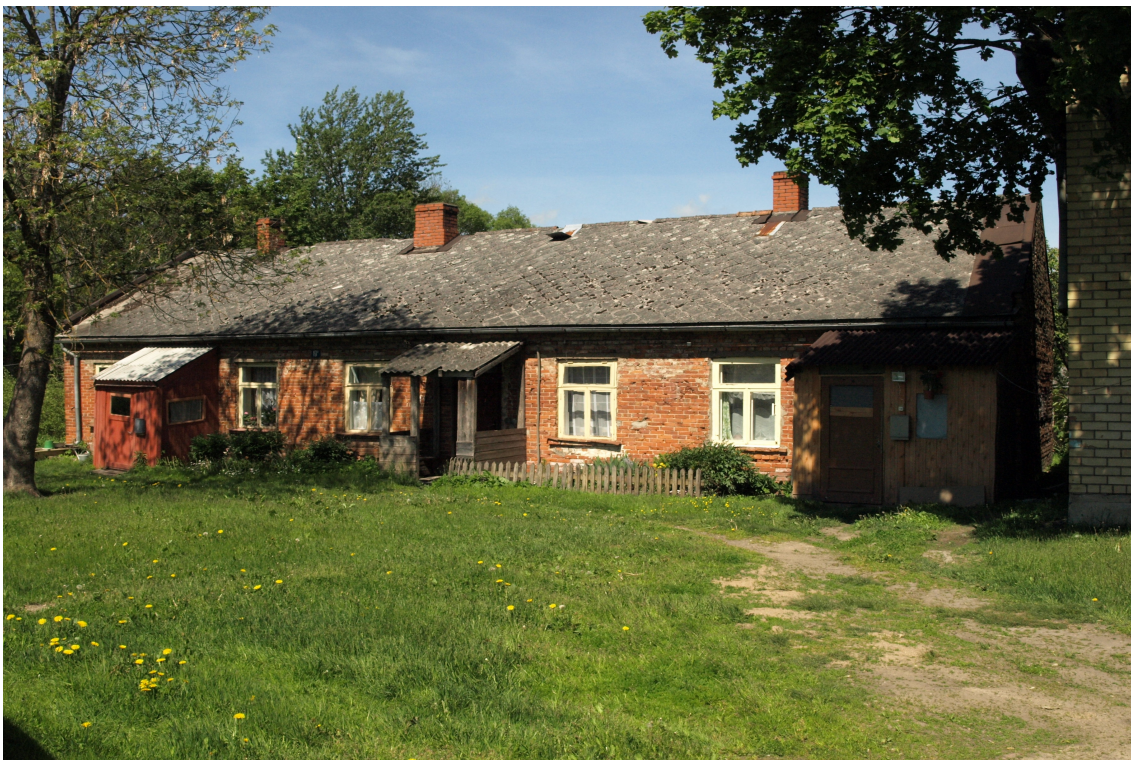
Jelgavas_19_62010230019002_fasade1 Skats uz ēku no dienvidaustrumiem.
