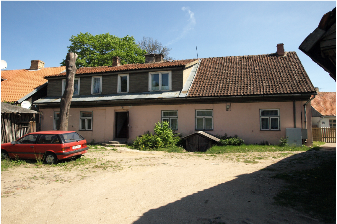
Jelgavas_19_62010230019001_fasade3 Ēkas dienvidrietumu fasāde. Jumta izbūve – 20.gs.2.puse.
