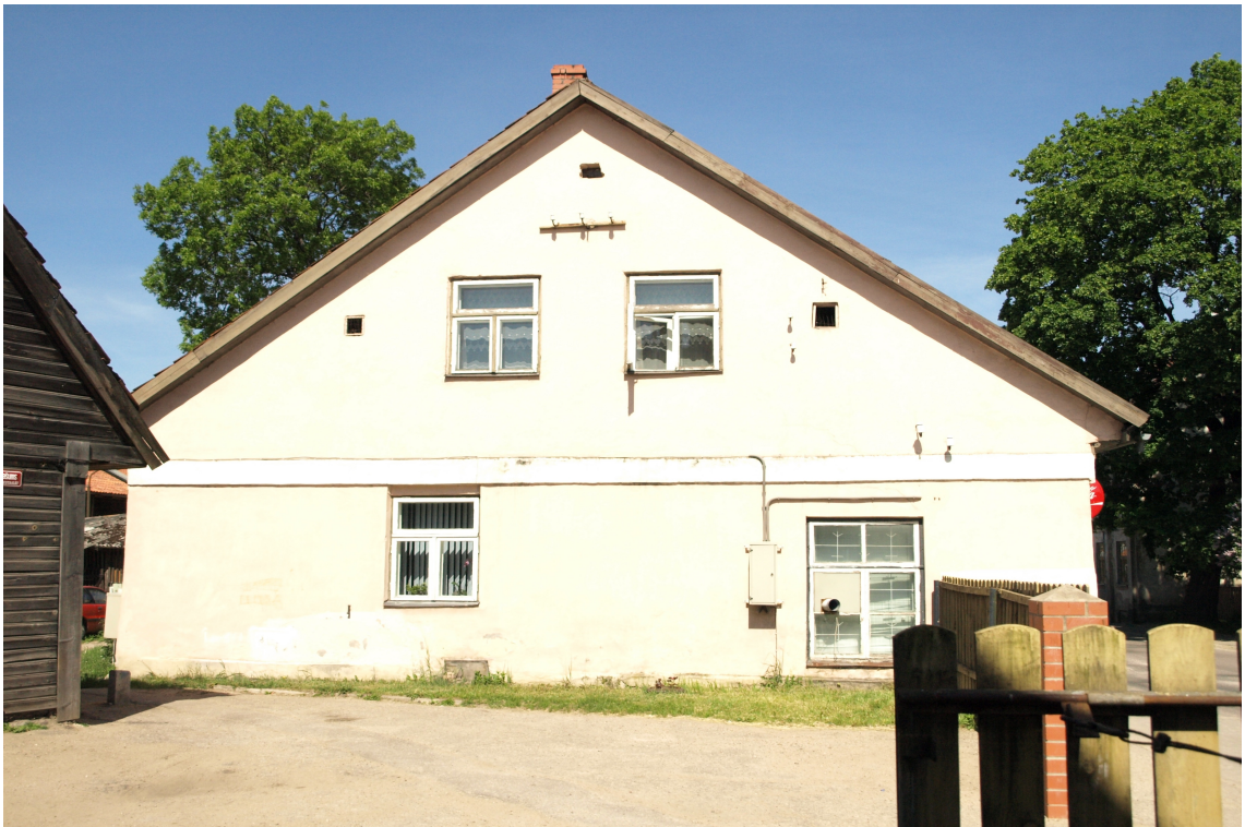
Jelgavas_19_62010230019001_fasade2 Ēkas dienvidaustrumu fasāde.
