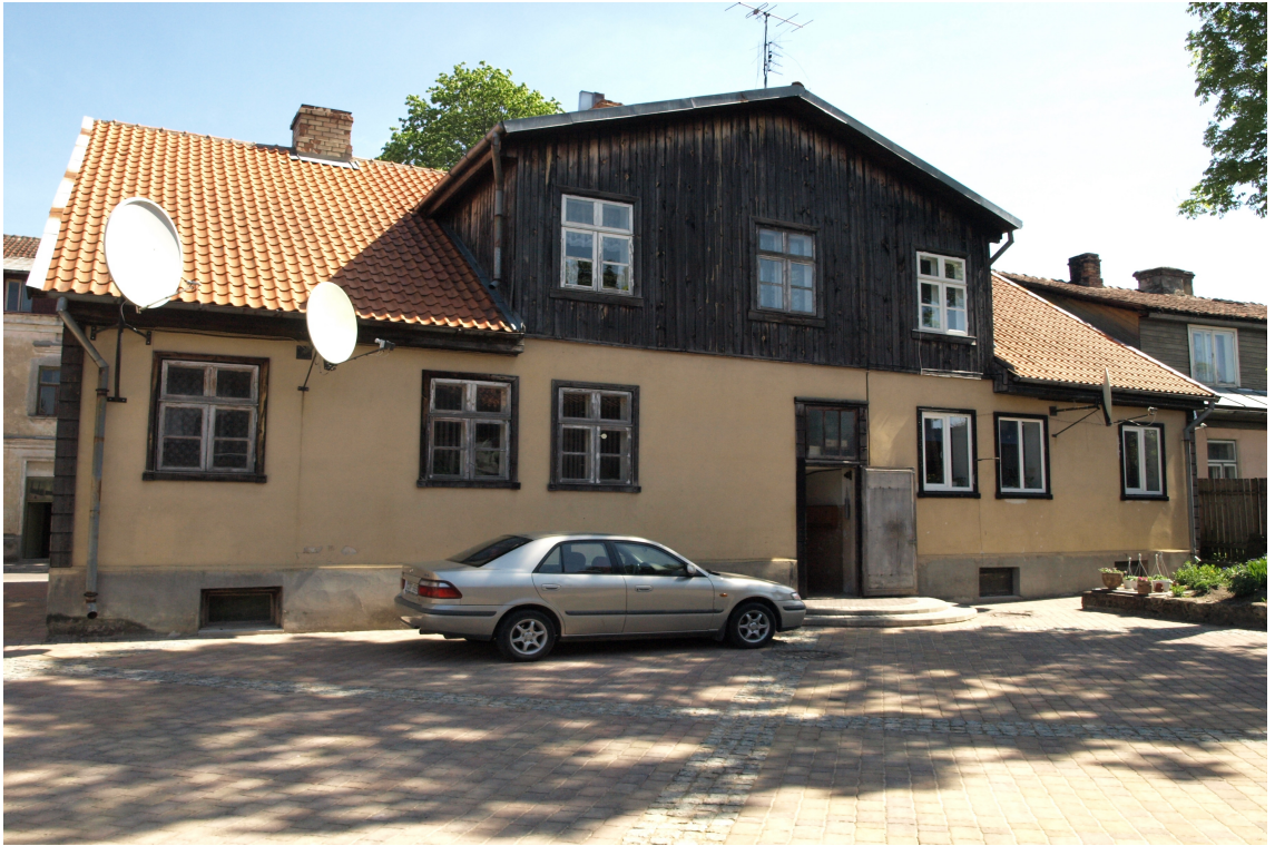
Jelgavas_17_62010230018001_fasade3 Ēkas dienvidrietumu fasāde.
