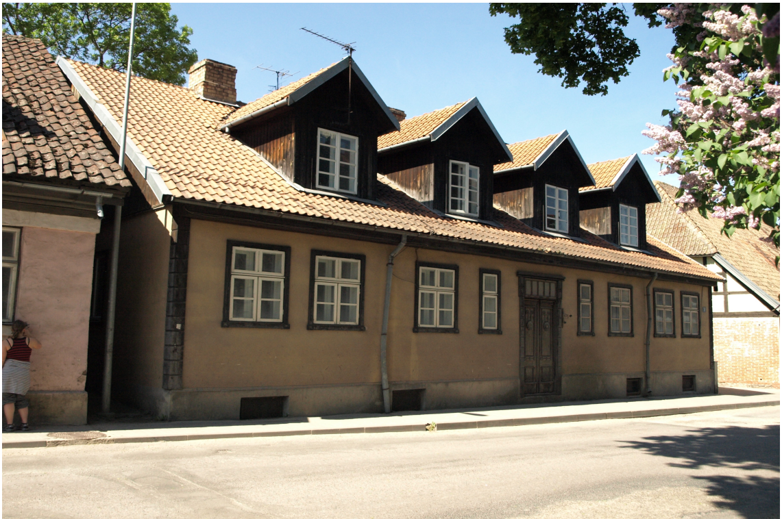
Jelgavas_17_62010230018001_fasade2 Skats uz ēku no austrumiem.
