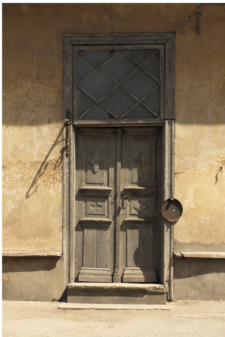
Jelgavas_16_62010220060001_durvis1 19.gs.1.puses durvis ar 1839.-1870to gadu sāk. virslogu un apmalēm.
