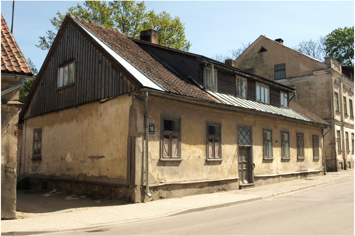
Jelgavas_16_62010220060001_fasade1 Skats uz ēku no ziemeļrietumiem. Jumta izbūve – 20.gs.2.puse.
