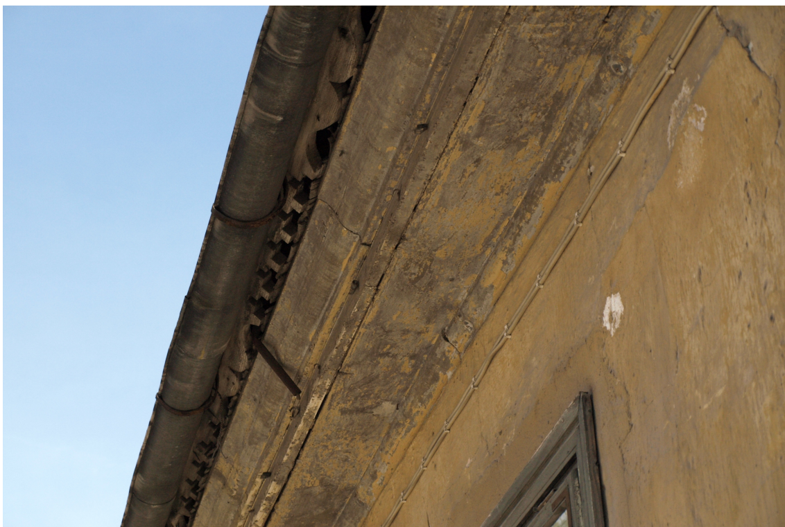
Jelgavas_16_62010220060001_dzega1 Sākotnējā (1839.-1870to gadu sāk.) dēļu dzega un kokā griezts aizsegdēlis.
