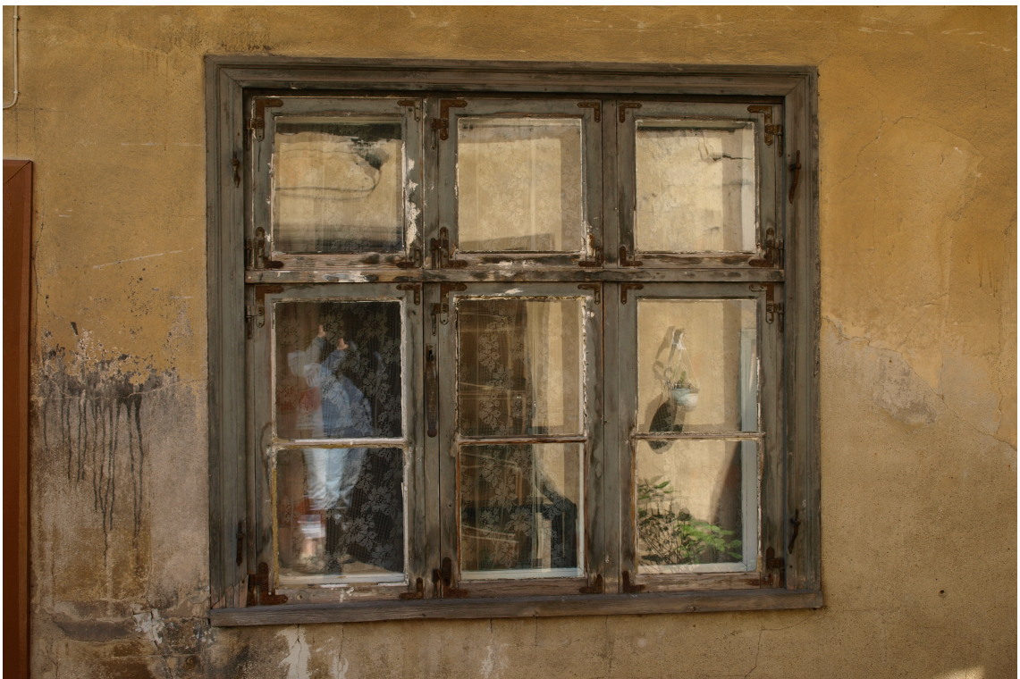
Jelgavas_16_62010220060001_logs3 20.gs.sāk. logs ar oriģinālo aprīkojumu un vēsturiskām seglīstēm.
