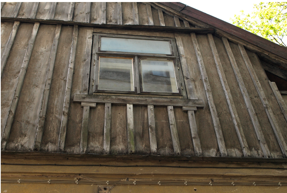
Jelgavas_16_62010220060001_fragments1 Zelmiņa fragments ar vēsturisku dēļu apšuvumu un loga apmalēm.
