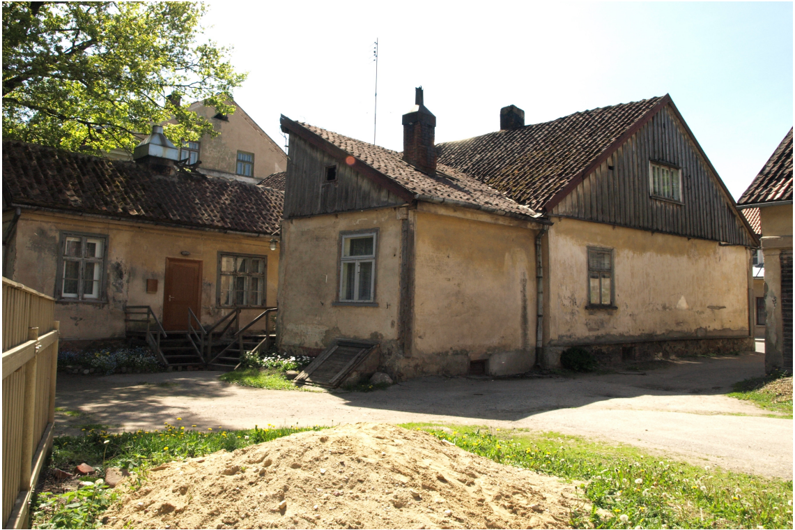
Jelgavas_16_62010220060001_fasade5 Skats uz ēku no ziemeļaustrumiem. Piebūves – 19.gs.3.cet.
