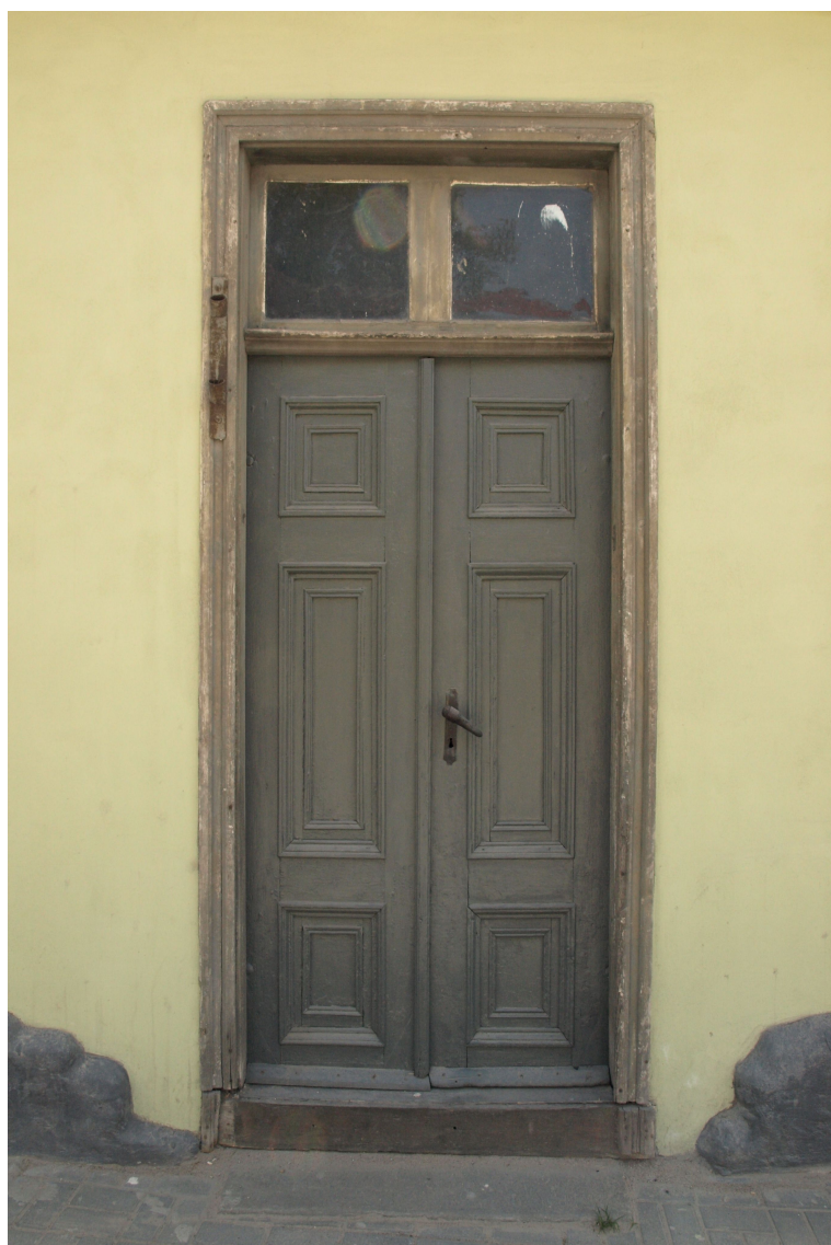
Jelgavas_15_62010230010001_durvis1 19.gs.pēd.cet. durvju komplekts ar oriģinālo aprīkojumu.
