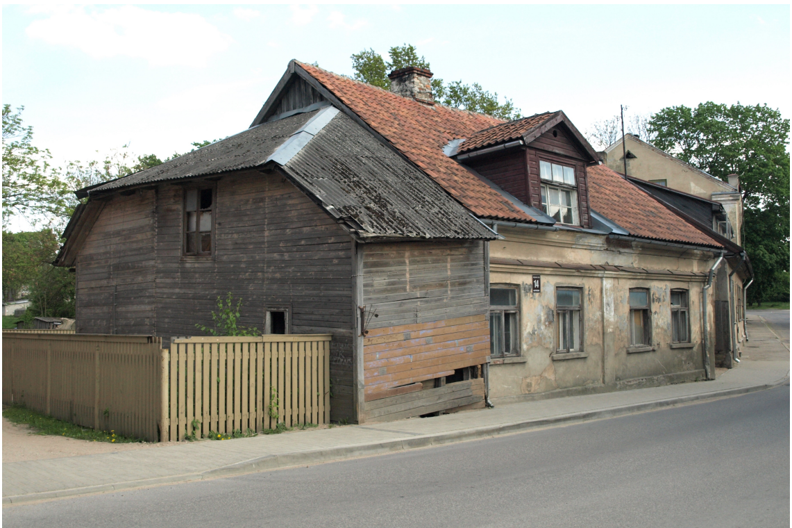
Jelgavas_14_62010220022001_fasade2 Skats uz ēku no ziemeļrietumiem. Koka piebūve – 20.gs.2.puse.
