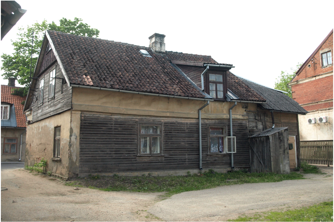
Jelgavas_14_62010220022001_fasade3 Skats uz ēku no dienvidaustrumiem.
