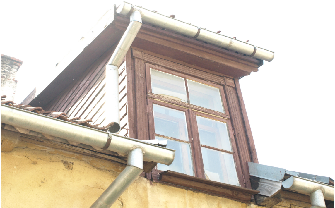
Jelgavas_14_62010220022001_fragments2 Vēsturiska jumta izbūve un 19.gs.1.cet. loga apmales.
