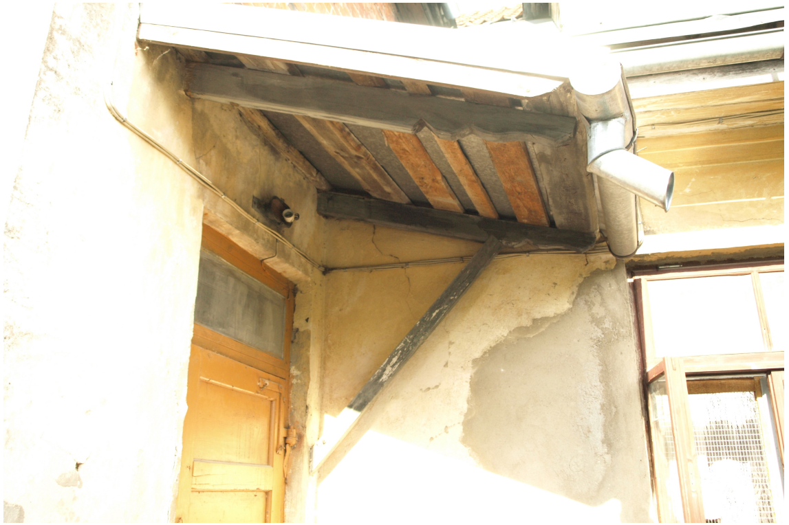
Jelgavas_13_62010230046001_detala1 Sākotnējā (1936.g.) jumtiņa konsoles.
