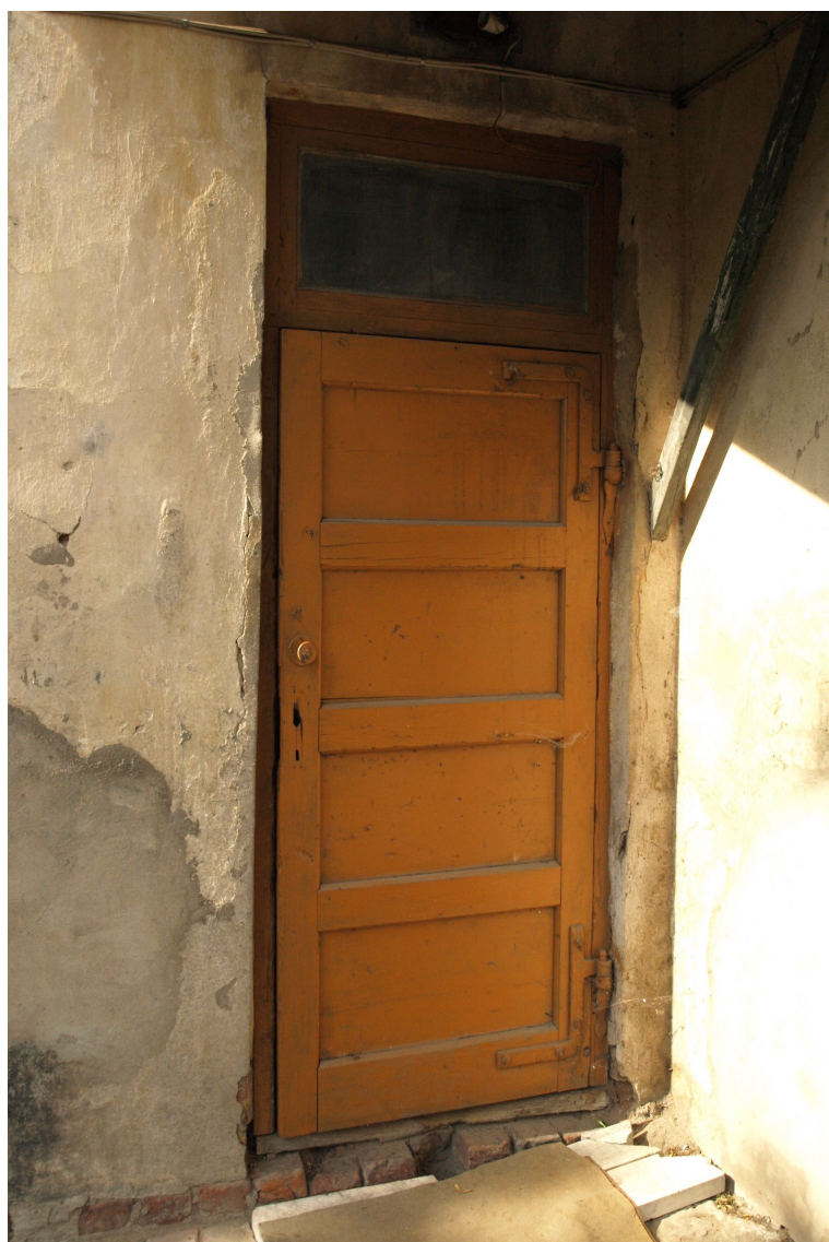
Jelgavas_13_62010230046001_durvis1 Sākotnējo (1936.g.) durvju komplekts ar oriģinālajām virām.
