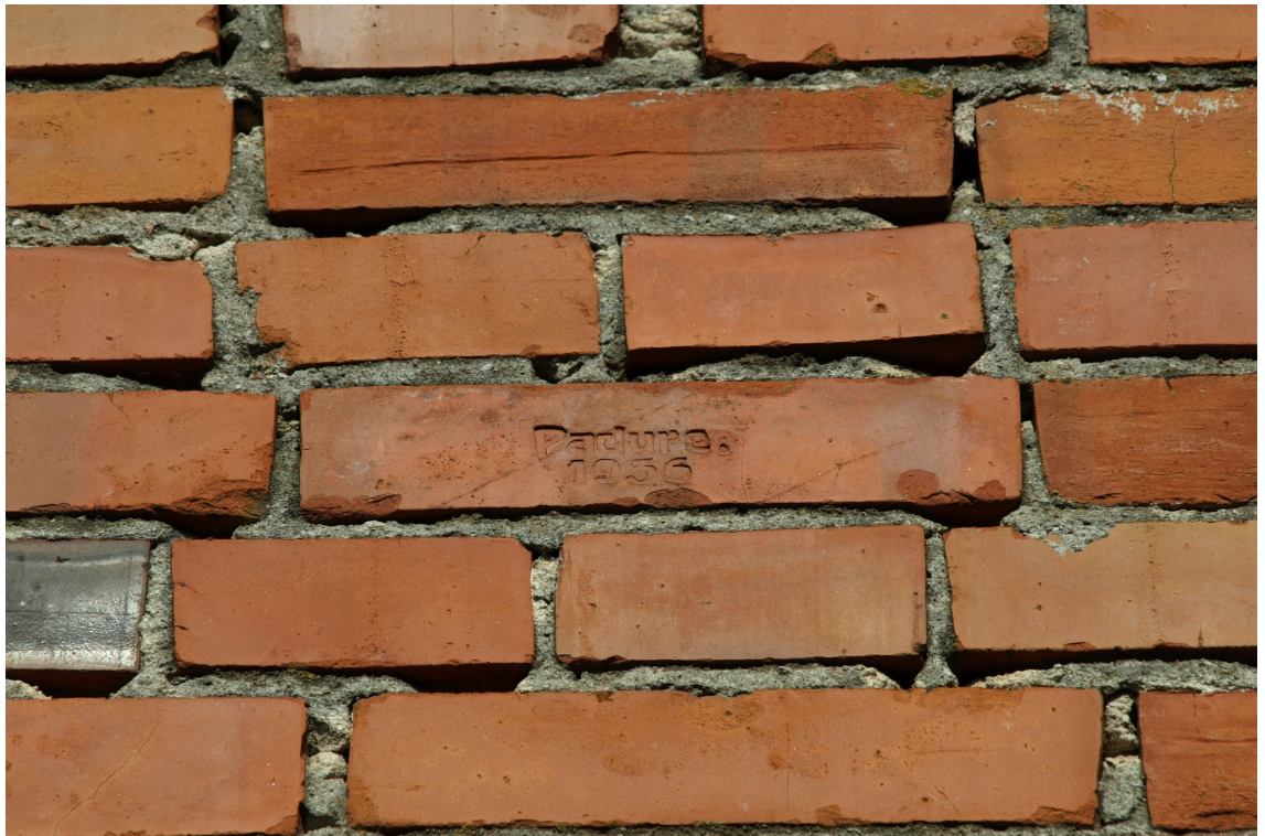
Jelgavas_13_62010230046001_detala4 Ķieģelis ar izgatavotāja marķi un datējumu.
