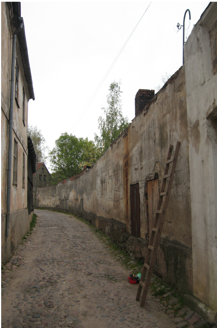
Jelgavas_12_62010220016002_003_004_ fasade1 Skats uz ēku aizmugures fasādi gar Rumbas ielu austrumu virzienā.
