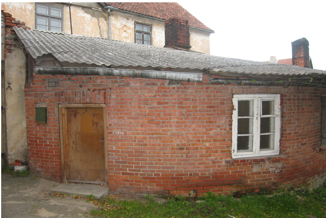
Jelgavas_12_62010220016002_003_004_fasade7 Skats uz ēkas lit. 002 dienvidrietumu stūri. Redzami 20.gs.sāk. logs ar oriģinālo aprīkojumu un vēsturiskas durvis.
