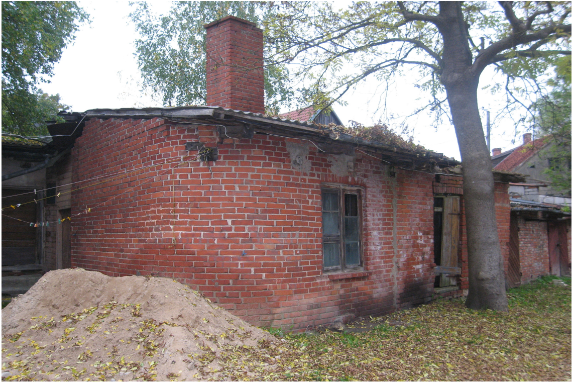
Jelgavas_12_62010220016002_003_004_fasade5 Skats uz ēku lit. 003 no dienvidrietumiem.
