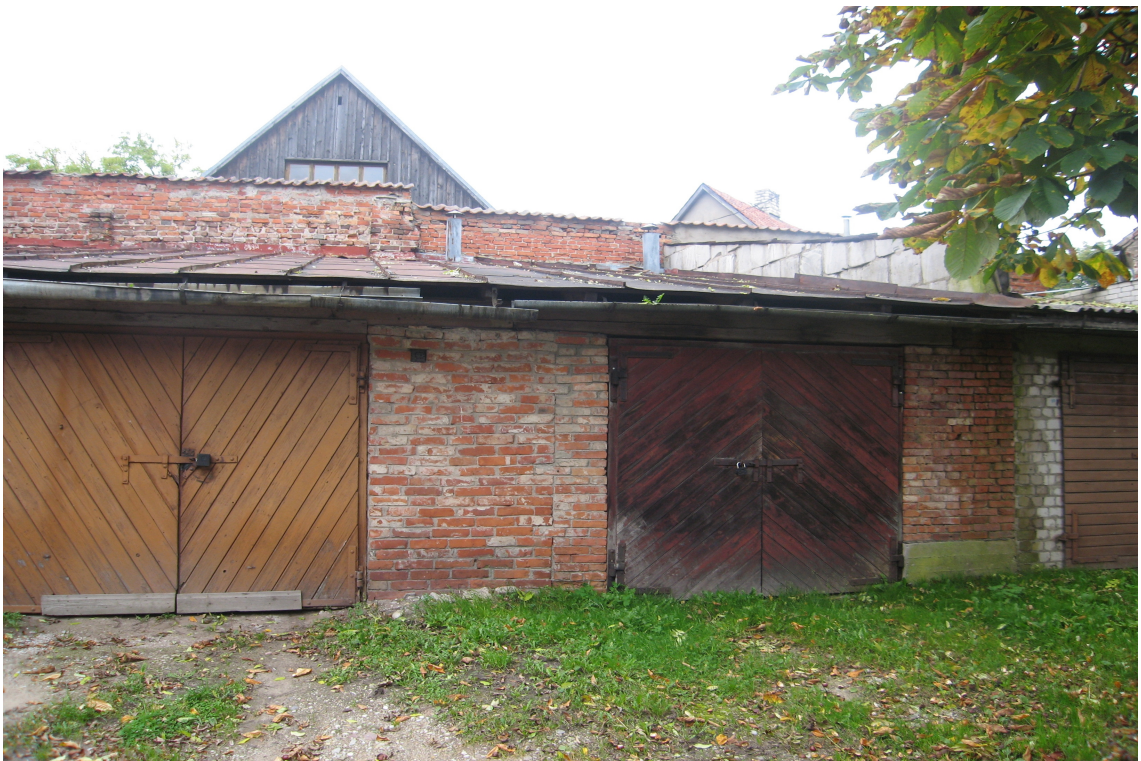
Jelgavas_12_62010220016002_003_004_fasade4 Ēkas lit. 004 dienvidu fasādes fragments. Esošā siena ar garažu vārtiem pilnībā pārbūvēta 20.gs.2.pusē.
