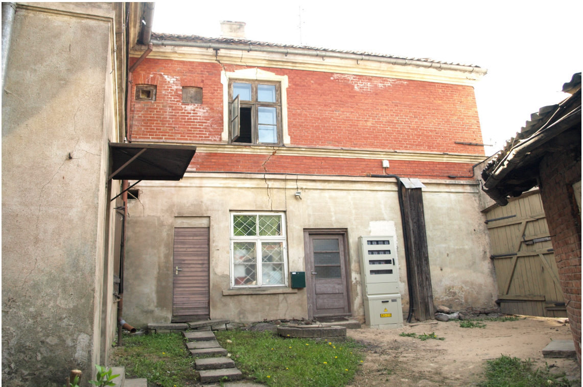
Jelgavas_12_62010220016001_fasade4 Ielas korpusa pagalma fasāde.
