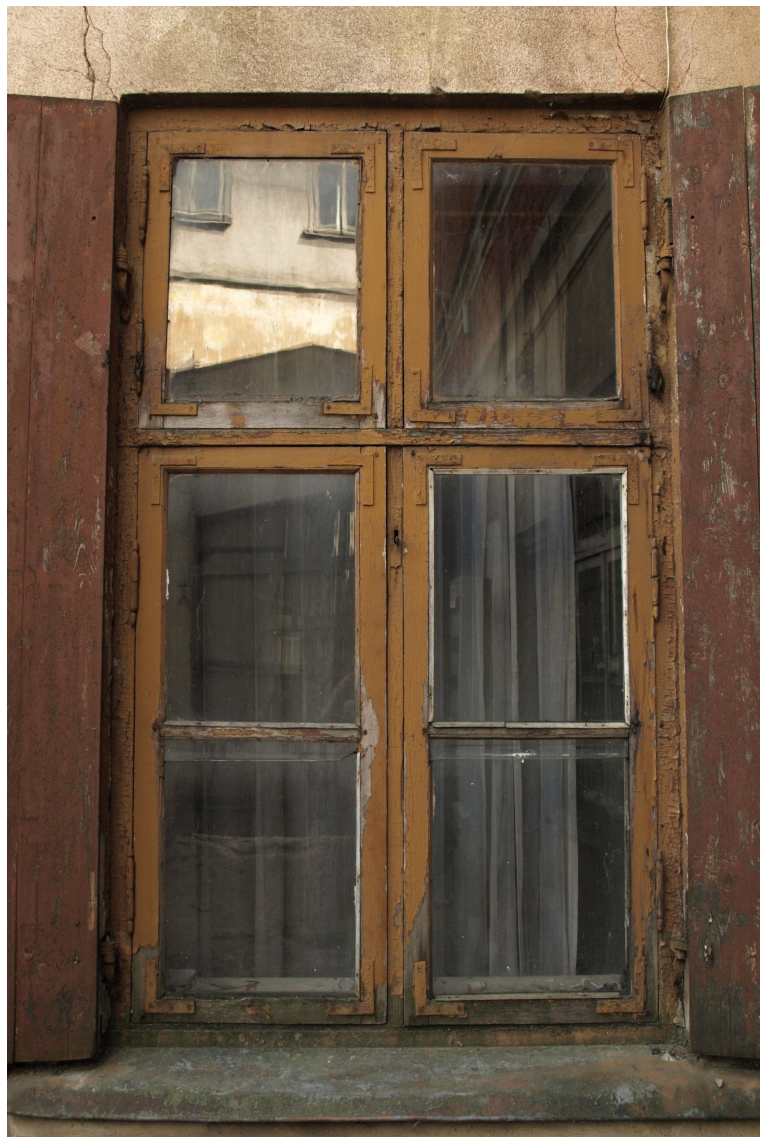
Jelgavas_12_62010220016001_logs1 Sākotnējais (1904.g.) logs ar oriģinālo aprīkojumu.
