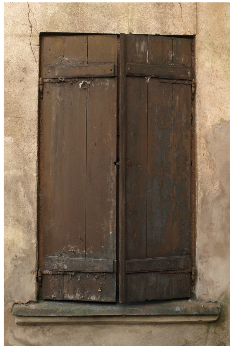
Jelgavas_12_62010220016001_slegi1 Sākotnējie (1904.g.) slēgi ar oriģinālo aprīkojumu.
