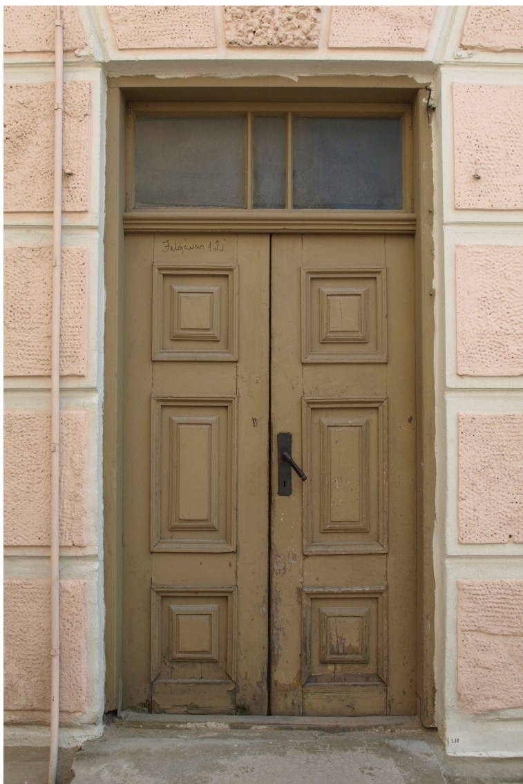
Jelgavas_12_62010220016001_durvis1 Sākotnējo (1904.g.) durvju komplekts ar oriģinālo aprīkojumu.
