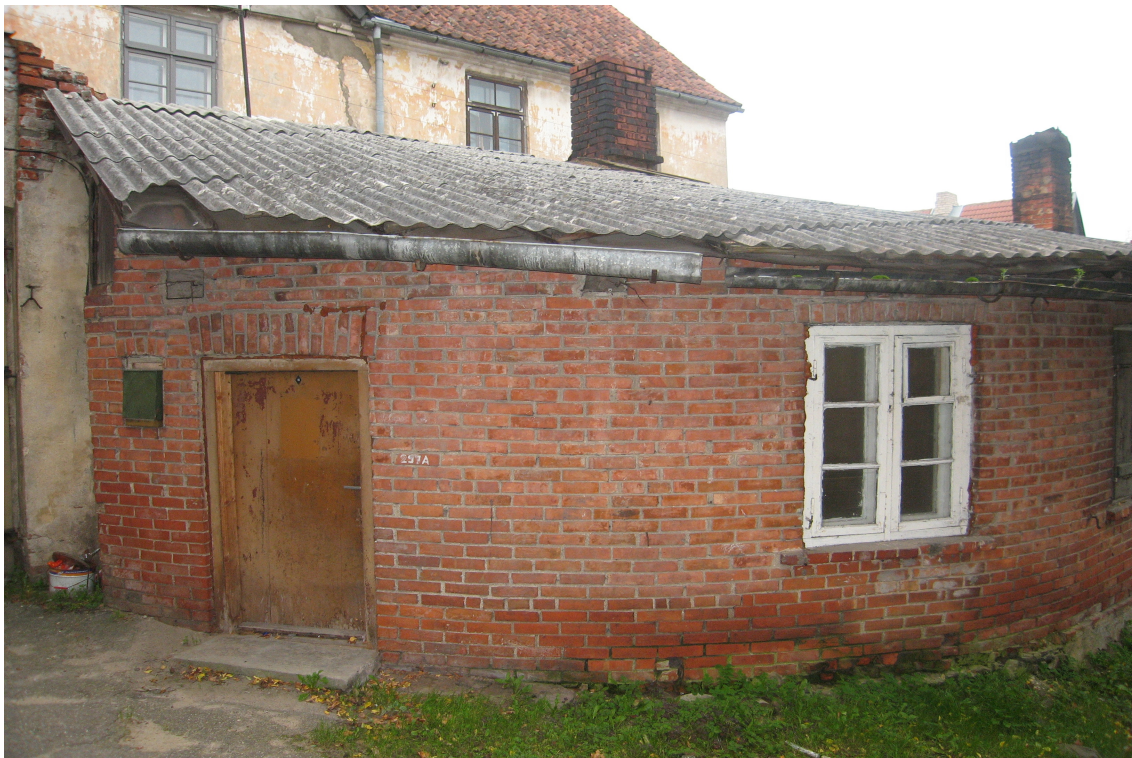
Jelgavas_12_62010220016002_003_004_fasade7 Skats uz ēkas lit. 002 dienvidrietumu stūri. Redzami 20.gs.sāk. logs ar oriģinālo aprīkojumu un vēsturiskas durvis.
