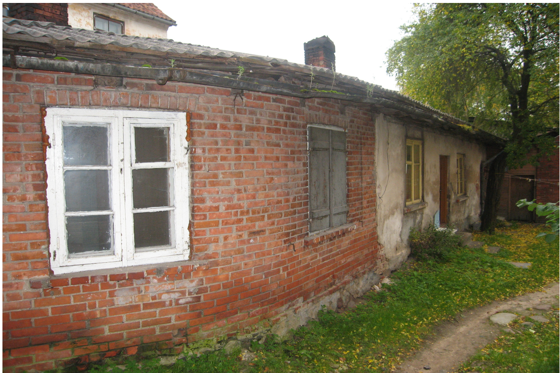
Jelgavas_12_62010220016002_003_004_fasade6 Skats uz ēku lit. 002 no dienvidrietumiem. Redzami 20.gs.sāk. logs un slēgi ar oriģinālo aprikojumu.
