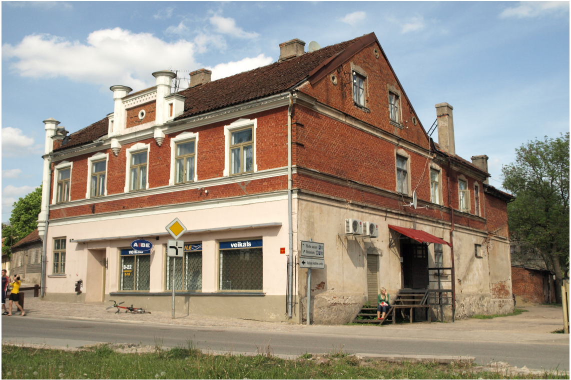
Jelgavas_12_62010220016001_fasade1 Skats uz ēku no dienvidrietumiem.
