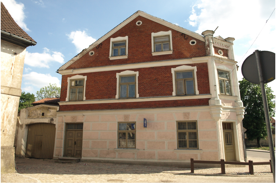
Jelgavas_12_62010220016001_fasade3 Ēkas ziemeļu fasāde.
