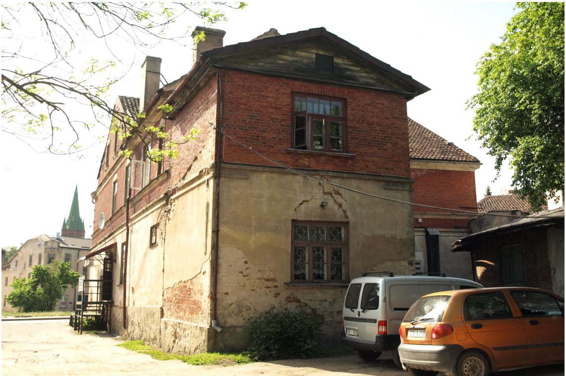
Jelgavas_12_62010220016001_fasade6 Skats uz ēku no dienvidaustrumiem.
