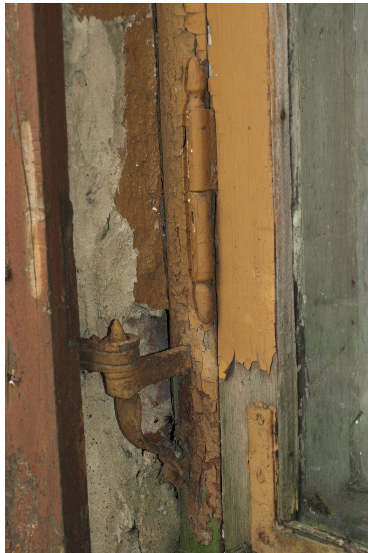
Jelgavas_12_62010220016001_logs2 Sākotnējais (1904.g.) loga aprīkojums un slēga vira.
