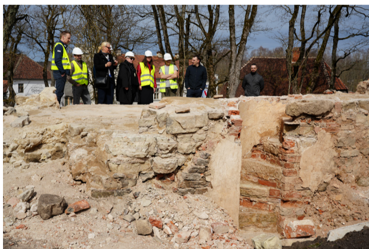
Pilsētas dārzā, kur zem neliela uzkalniņa līdz mūsdienām saglabājusies daļa no kādreiz varenās Livonijas ordeņa pils, būvdarbu laikā atklāti mūra sienu fragmenti, kāpnes un dažādas būvdetaļas.
