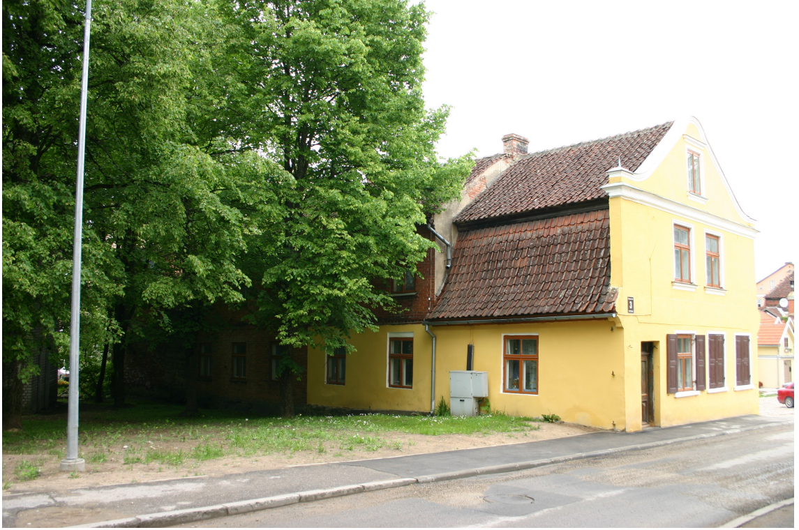
Jelgavas_3_62010220084001_fasade3 Skats uz ēku no dienvidaustrumiem.
