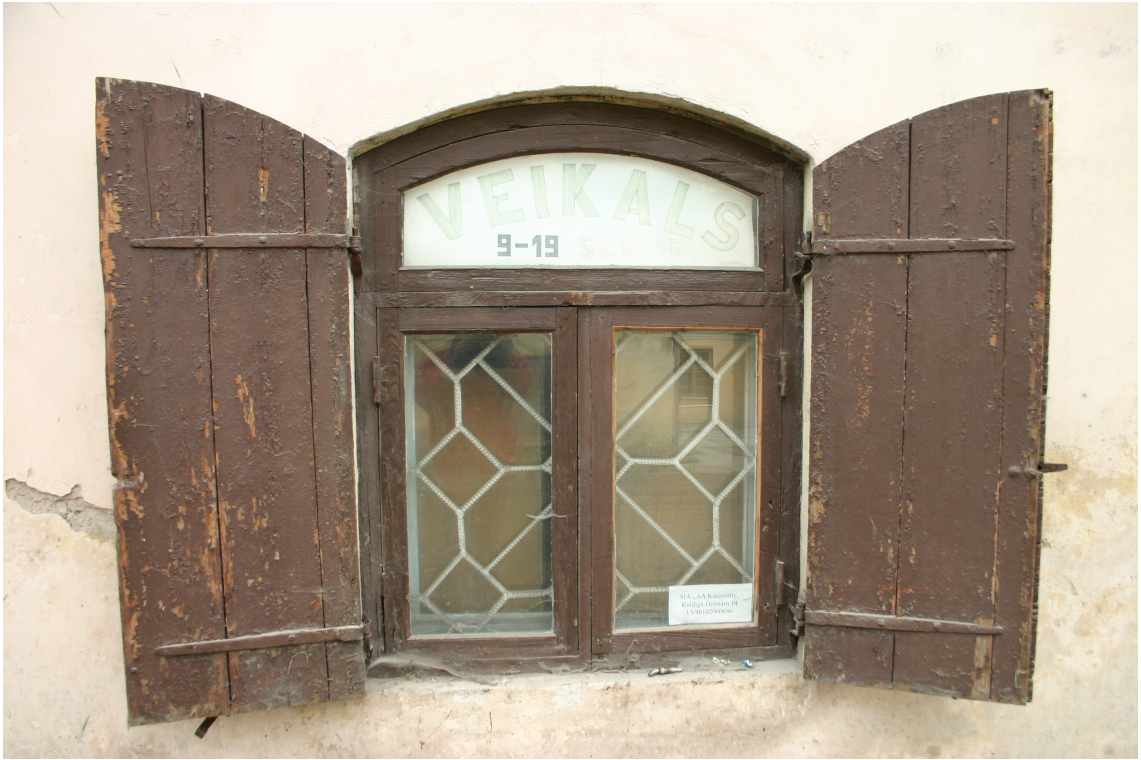
Jelgavas_2_62010220085001_slegi2 Vēsturiski slēgi ar oriģinālo aprīkojumu.
