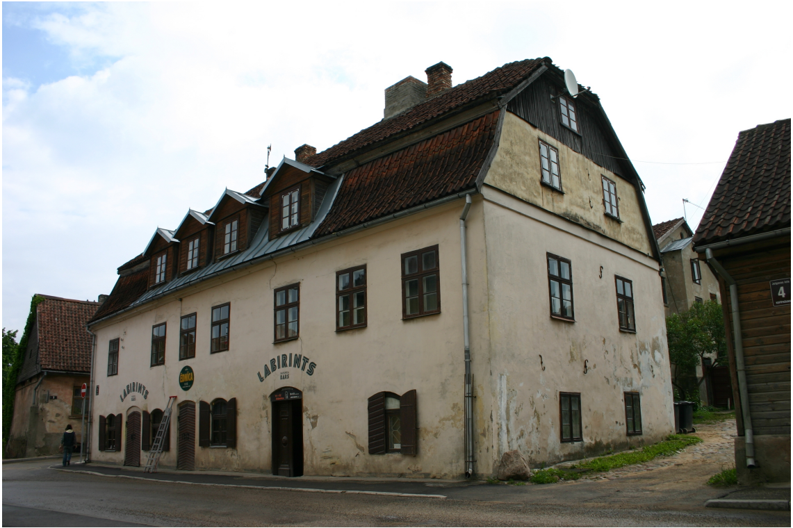
Jelgavas_2_62010220085001_fasade3 Skats uz ēku no rietumiem.
