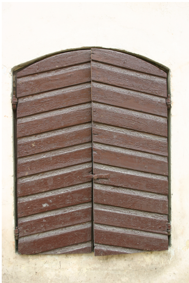
Jelgavas_2_62010220085001_slegi1 Vēsturiski slēģi ar oriģinālo aprīkojumu.
