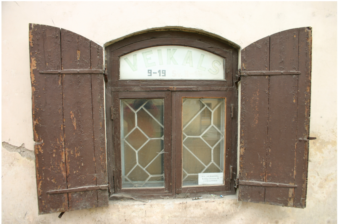
Jelgavas_2_62010220085001_slegi2 Vēsturiski slēgi ar oriģinālo aprīkojumu.
