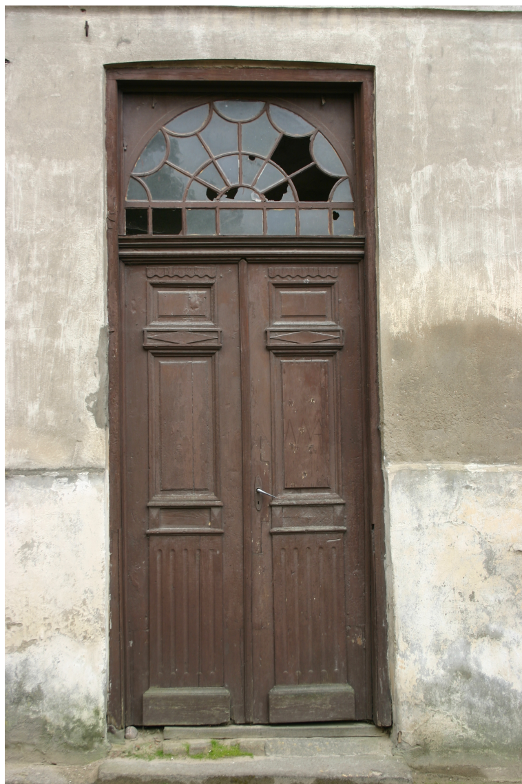
Jelgavas_2_62010220085001_durvis5 20.gs.sāk. pagarinātas 19.gs.2.cet. durvis. Virslogs, domājams, izveidots 20.gs.sāk.
