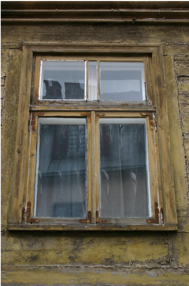
Jelgavas_1_62010220083001_logs2 20.gs.1.cet. logs ar oriģinālo aprīkojumu.
