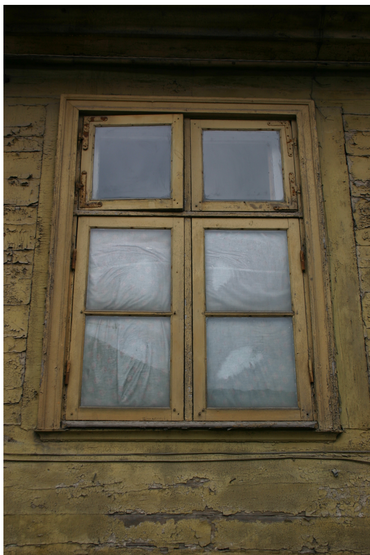
Jelgavas_1_62010220083001_logs1 19.gs.3.cet. logs ar oriģinālo aprīkojumu. Apakšējās vērtnes sekundāras.
