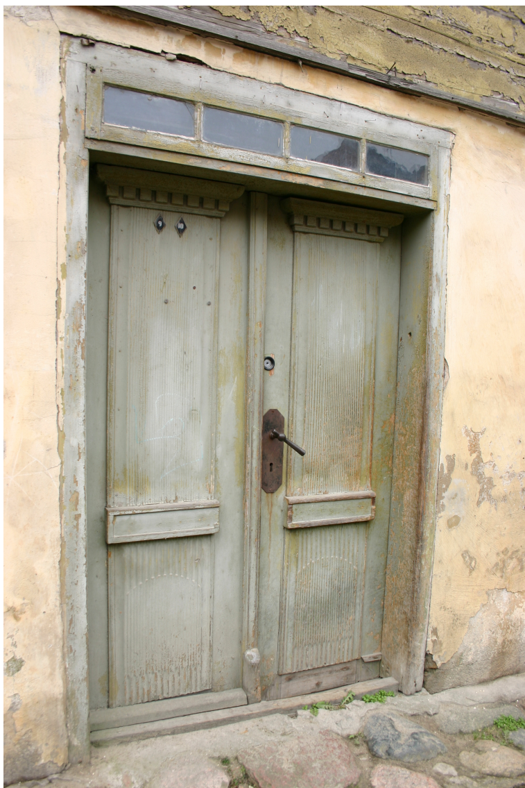
Jelgavas_1_62010220083001_durvis1 Sākotnējs (1797.-1813.g.) durvju komplekts. Aprīkojums – 19.gs.2.puse.
