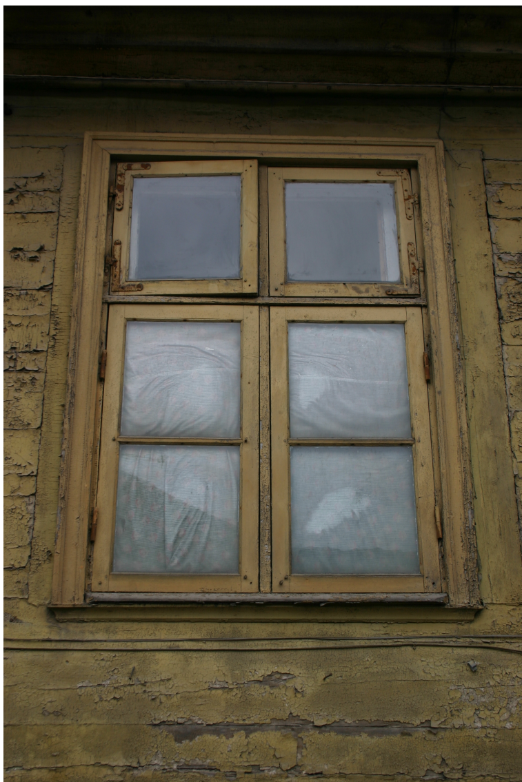
Jelgavas_1_62010220083001_logs1 19.gs.3.cet. logs ar oriģinālo aprīkojumu. Apakšējās vārtnes sekundāras.
