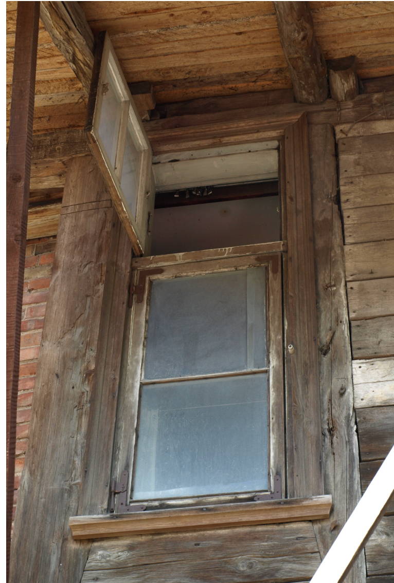
Dzirnavu_8_62010230038002_logs1 Sākotnējs (20.gs.sāk.) logs ar oriģinālo aprīkojumu un apmales, palodze.
