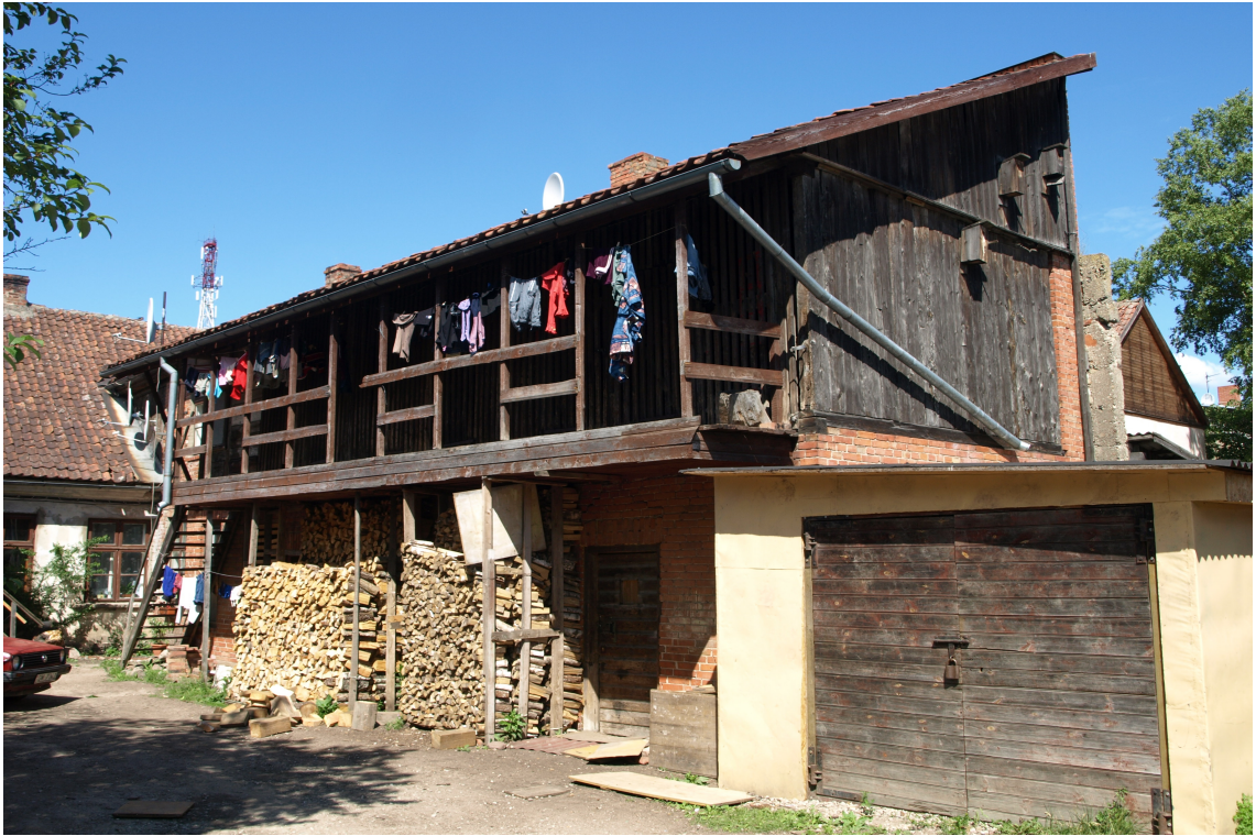
Dzirnavu_8_62010230038002_fasade1 Skats uz ēku no dienvidaustrumiem. Pašreizējā koka galerija – 20.gs.2.puse.
