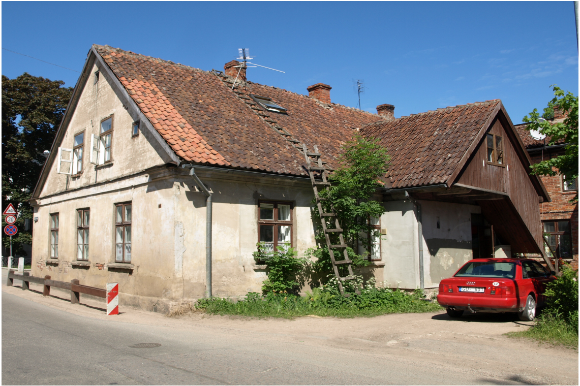
Dzirnavu_8_62010230038001_fasade3 Skats uz ēku no dienvidaustrumiem.
