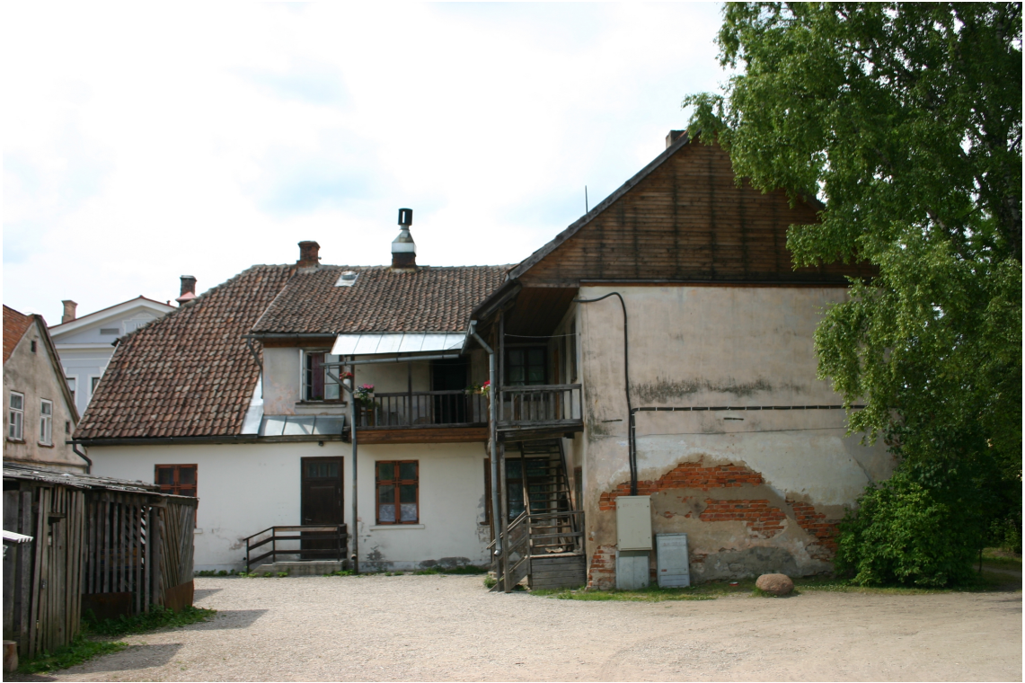
Dzirnavu_6_62010230054001_fasade3 Skats uz ēku no austrumiem. Koka galerija – 20.gs.2.puse.
