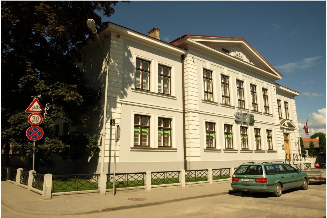
Dzirnavu_5_62010140016001_fasade1 Skats uz ēku no dienvidaustrumiem.
