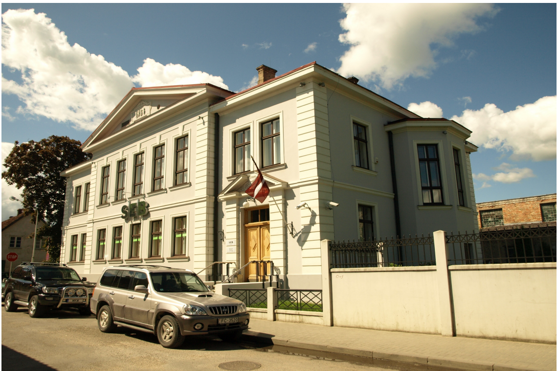
Dzirnavu_5_62010140016001_fasade2 Skats uz ēku no ziemeļaustrumiem.
