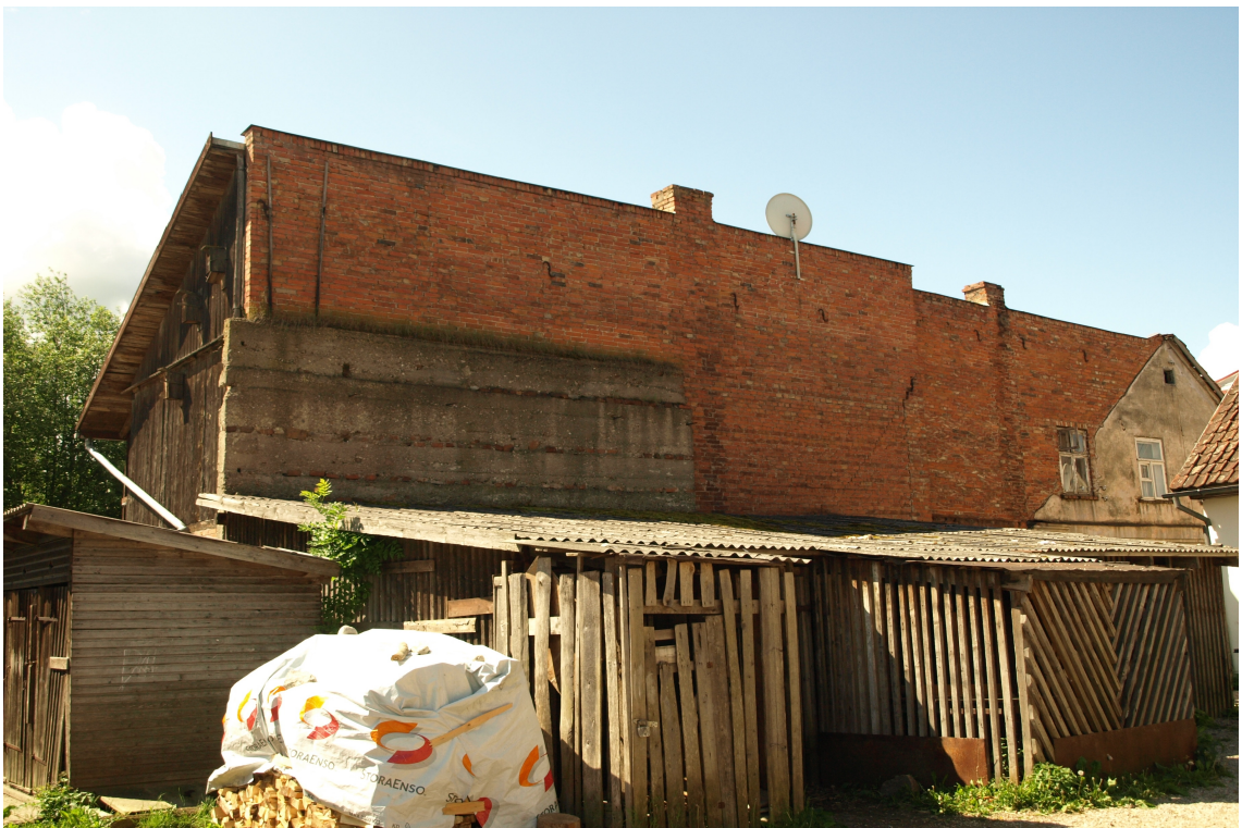
Dzirnavu_8_62010230038002_fasade2 Skats uz ēku no ziemeļaustrumiem.
