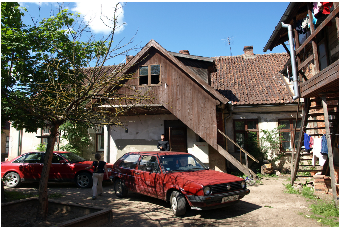
Dzirnavu_8_62010230038001_fasade4 Skats uz ēku no austrumiem. Redzama 20.gs.2.pusē pārveidotā piebūve ar uzeju un 20.gs.2.puses jumta izbūve.
