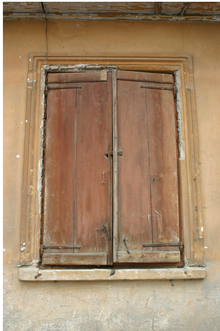
Dzirnavu_6_62010230054001_slegi1 Sākotnējie (19.gs.3.cet.) slēgi ar oriģinālo aprīkojumu.
